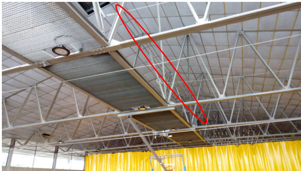
Detall barana existent passarel·la
