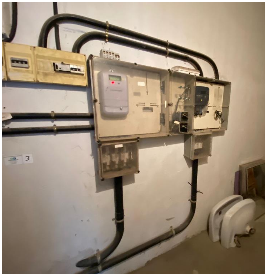
Figura 8. Imagen de los dos contadores existentes dentro de la escuela.
