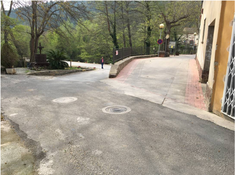
CARRER DEL PORTAL I BAIXADA CAP AL PONT SOBRE LA MUGA
