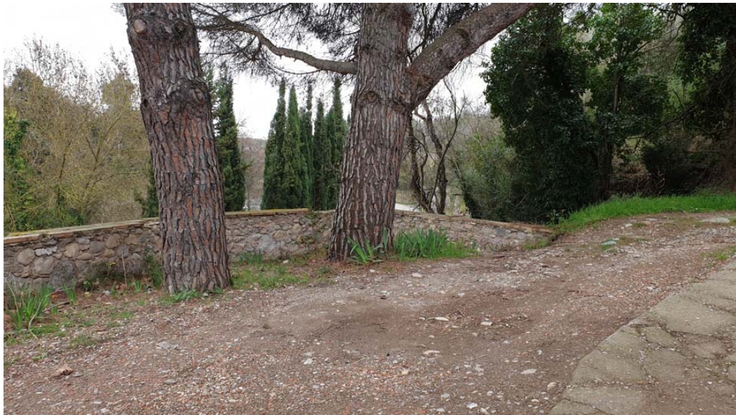
CARRER FIGUERES. ÀMBITS ON EXTENDRE UNA SUBBASE DE SAULÓ, FINALITZATS ELS TREBALLS DE PAVIMENTACIÓ
