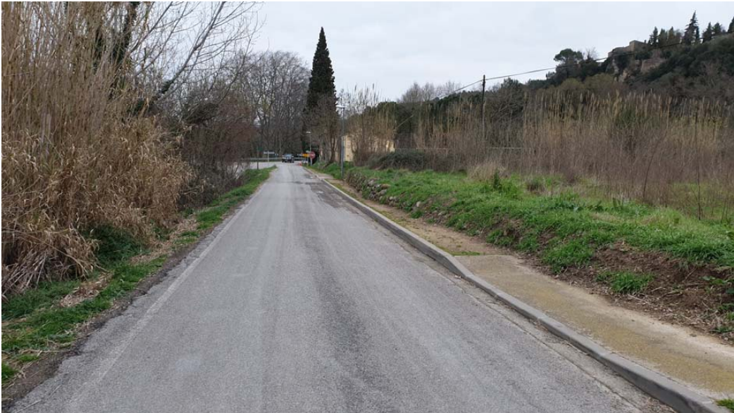
TRAM DEL CAMÍ D'ACCÉS AL NUCLI DE LES ESCAULES DES DE LA CRTA. GIV-504. ÀMBIT DE VORADA EXISTENT I GUALS A ENDERROCAR PER LA FORMACIÓ D'UN VORERA DE FORMIGÓ COLOREJAT A NIVELL AMB LA RIGOLA I ASFALT.
