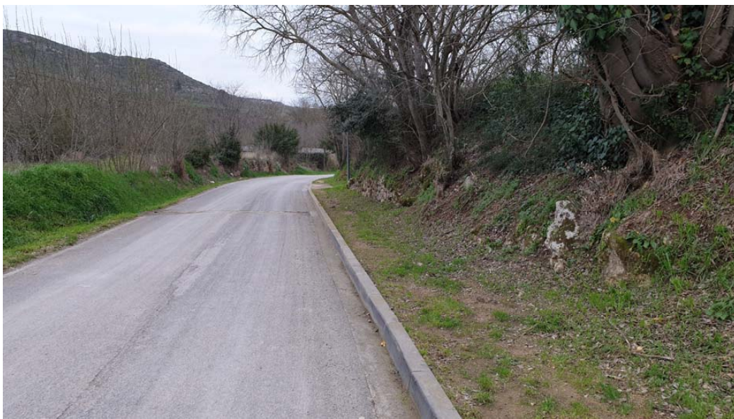
TRAM DEL CAMÍ D'ACCÉS AL NUCLI DE LES ESCAULES DES DE LA CRTA. GIV-504. VORADA DE FORMIGÓ EXISTENT A MANTENIR I NOVA PAVIMENTACIÓ FINS A TALÚS NATURAL.
