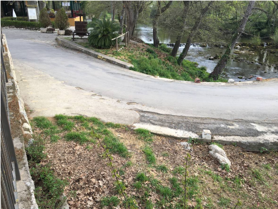
INICI DEL PONT SOBRE LA MUGA
