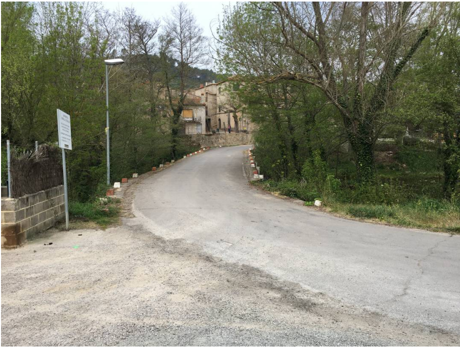
VISTA DEL PONT SOBRE LA MUGA I EL NUCLI DE BOADELLA D'EMPORDÀ DE FONS
