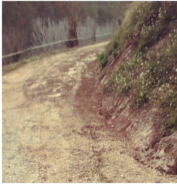
Reperfilat base talús i cuneta
