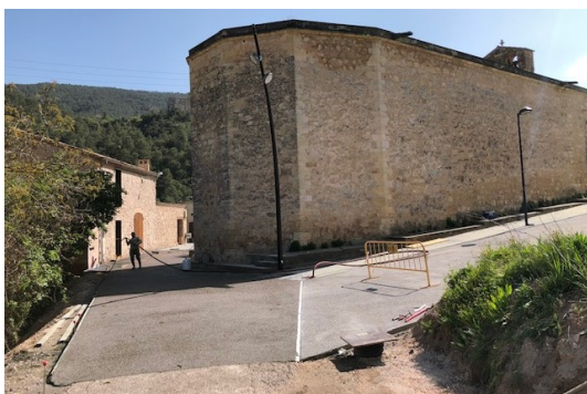
Final-inici de l'àmbit d'obres, a límit la de la urbanització executada al nucli.
