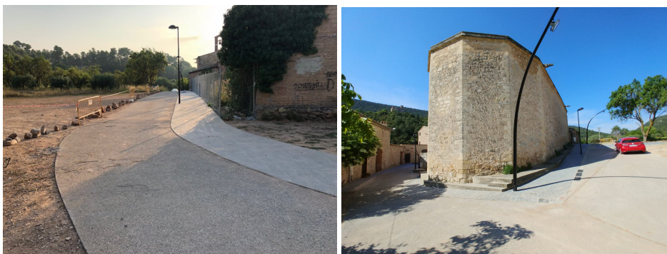
Imatges de l'obra urbanitzadora fase 1
