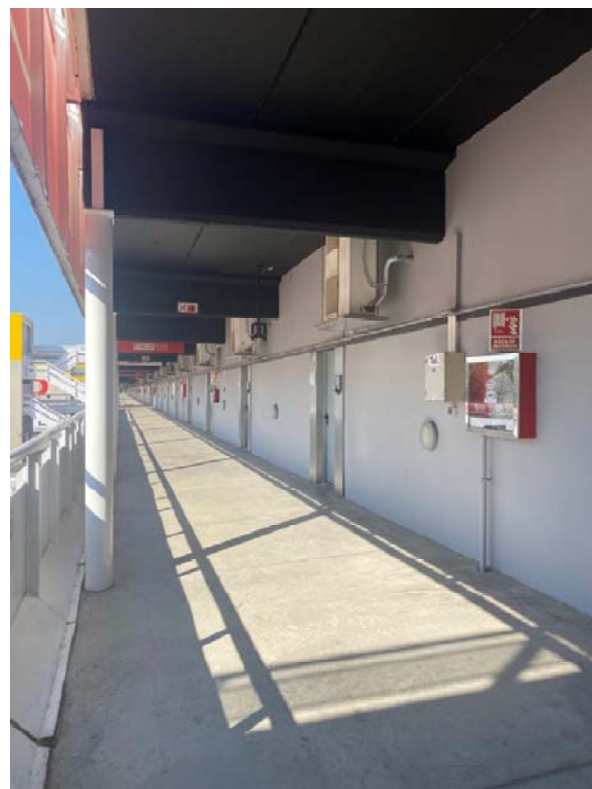
F02 Passadís d'accés als Pisos Box
