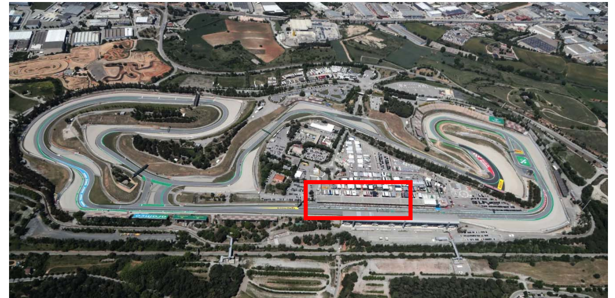
Imatge 1: Vista aèria del paddock del circuit de Barcelona-Catalunya. En vermell s'ha indicat l'edifici a on es troben les sales.
