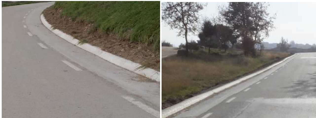
Cunetes de formigó
