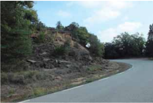
Imatge 01. Vista general tram PK 1800.00-1700.00
