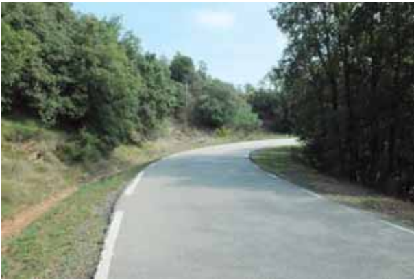
Imatge 02. Vista general tram PK 1700.00-1600.00
