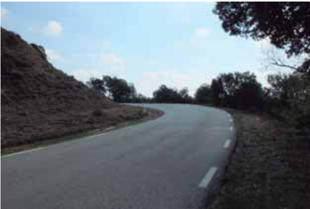
Imatge 03. Vista general tram PK 1600.00-1500.00
