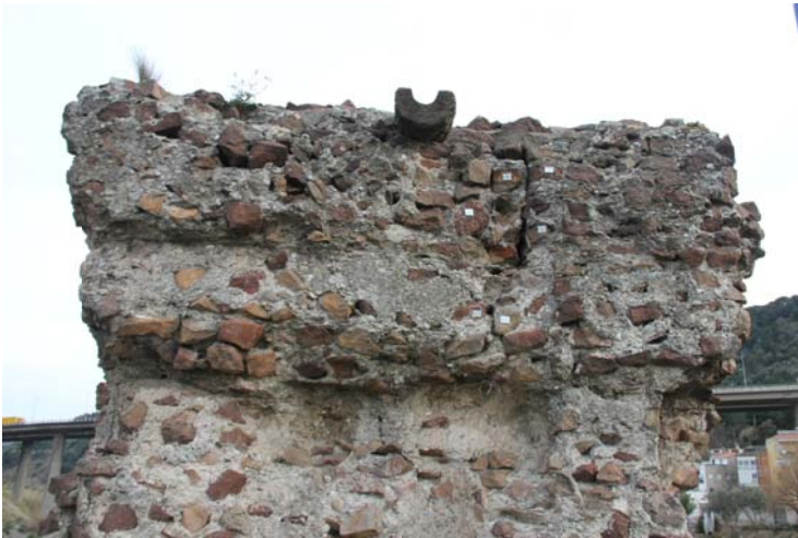
Pèrdua de carreus i esquerda al morter de rebliment.
