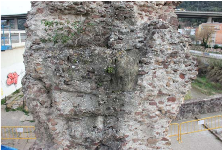
Pèrdua de carreus, arenització i pàtina biogènica.
