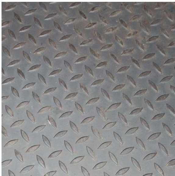
Acabat de paviment de rampa.
