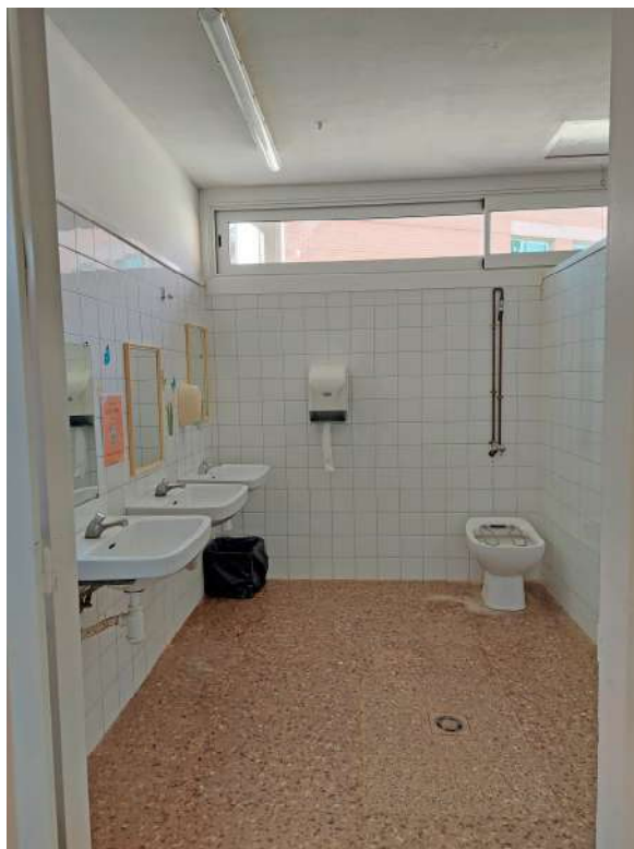
Vista interior zona àmbit 1
