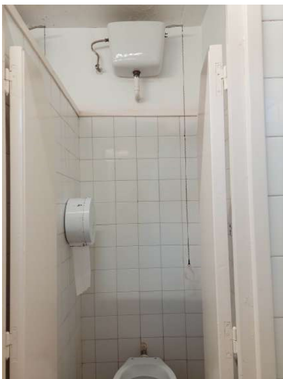
Vista interior zona àmbit 1
