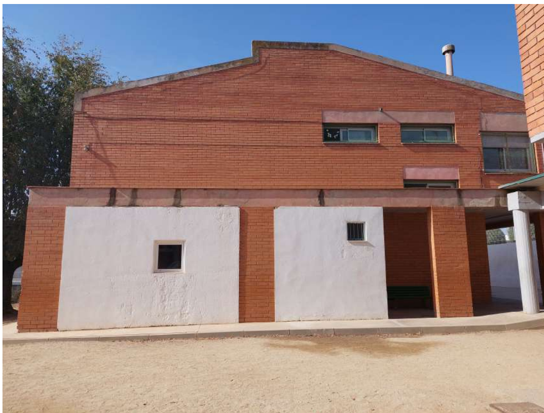
Vista exterior edifici primària
