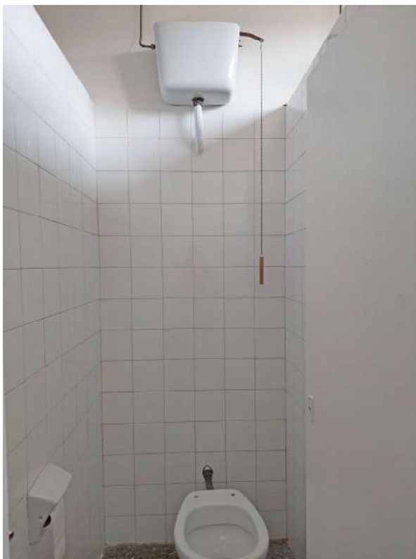
Vista interior planta primera àmbit 4
