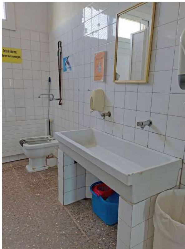
Vista interior planta primera àmbit 4
