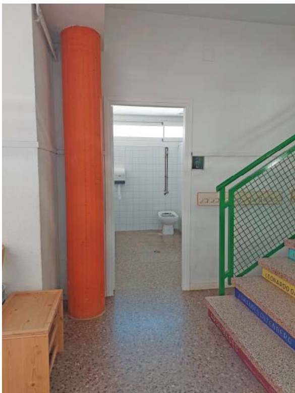
Vista interior zona àmbit 1
