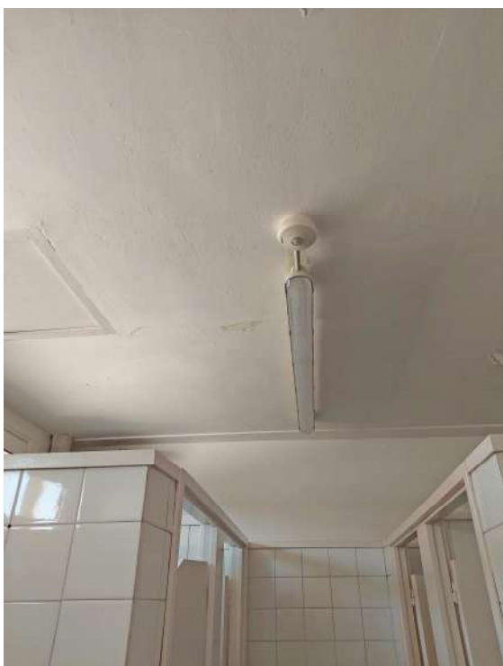
Vista interior zona àmbit 1
