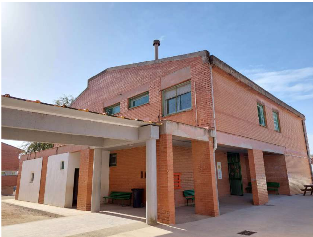
Vista exterior edifici primària
