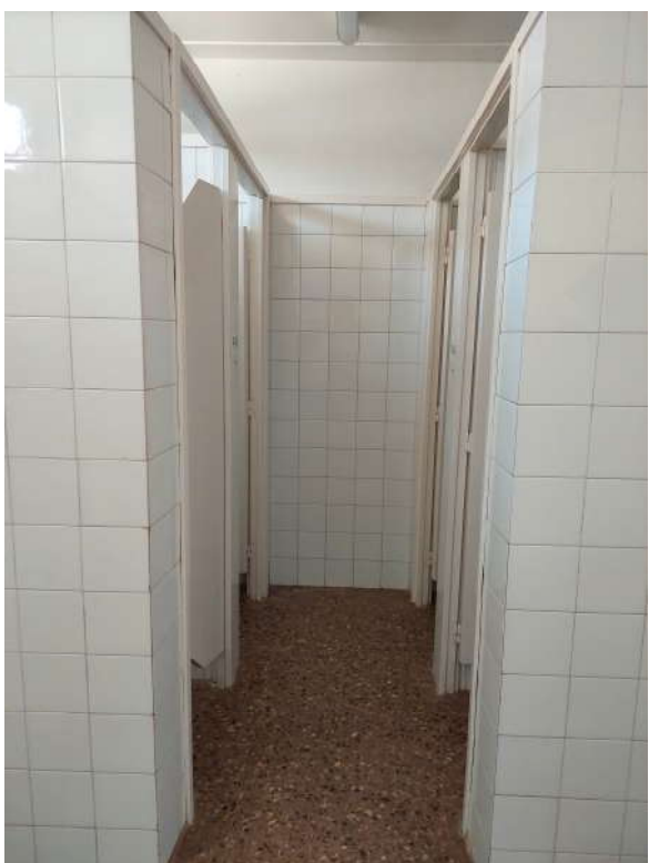
Vista interior zona àmbit 1
