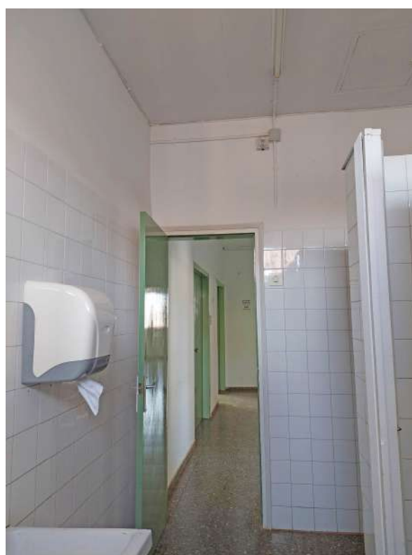
Vista interior planta primera àmbit 4
