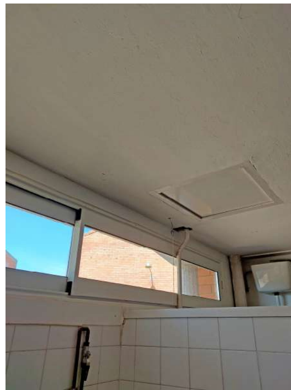
Vista interior zona àmbit 1
