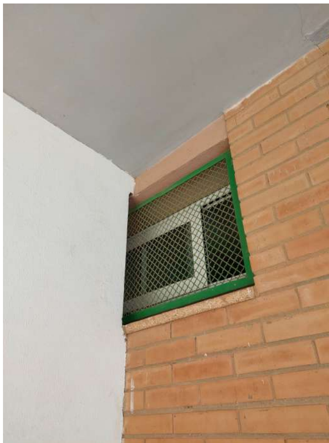
Vista exterior edifici primària
