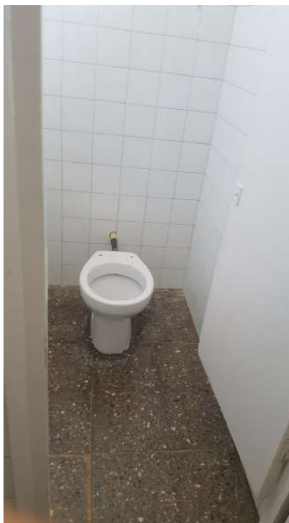
Vista interior zona àmbit 1
