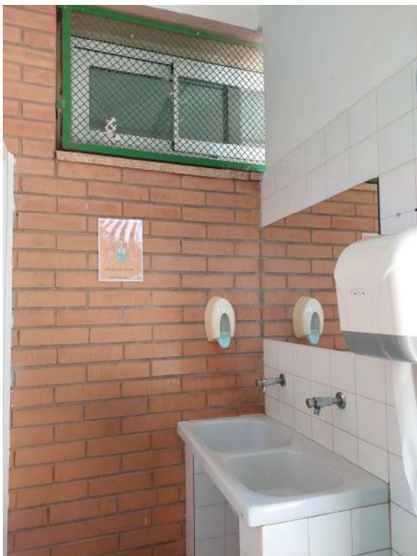
Vista interior zona àmbit 3
