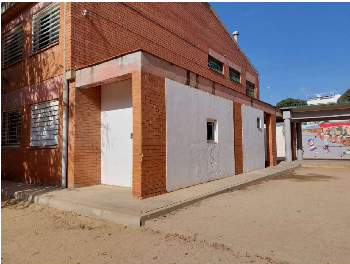
Vista exterior edifici primària
