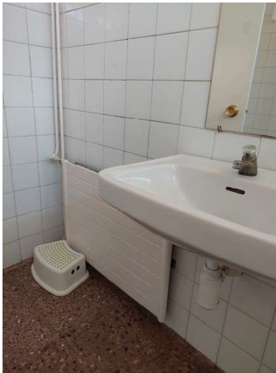
Vista interior zona àmbit 1
