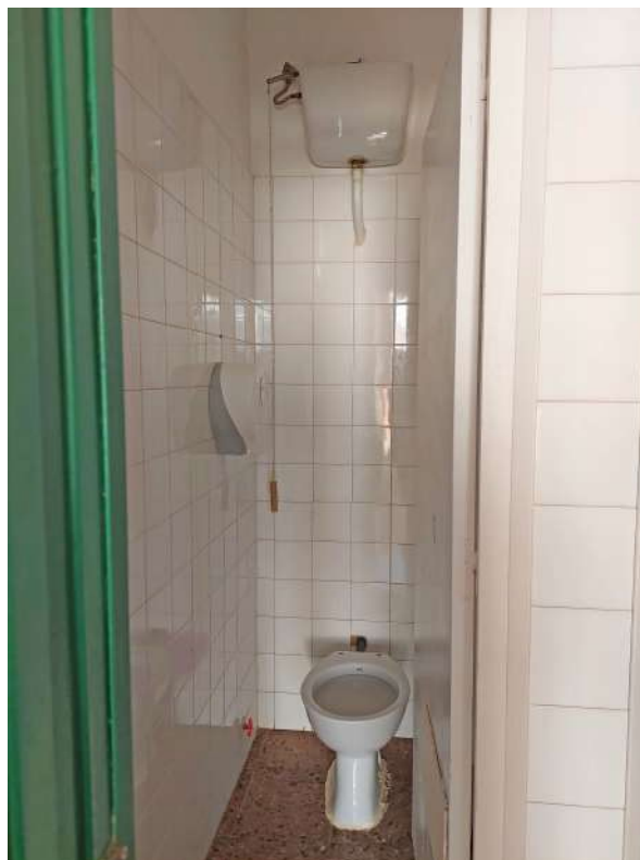
Vista interior zona àmbit 3
