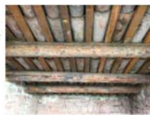
S7 SOSTRE 7: Sostre amb bigues de fusta i teules a salt de garsa
