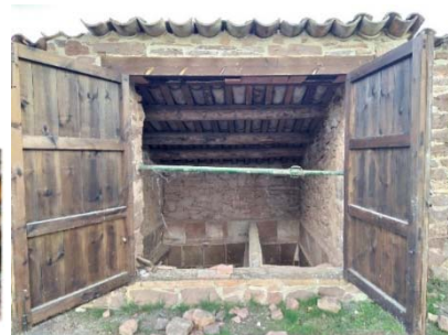
S7 SOSTRE 7: Sostre amb bigues de fusta i teules a salt de garsa
