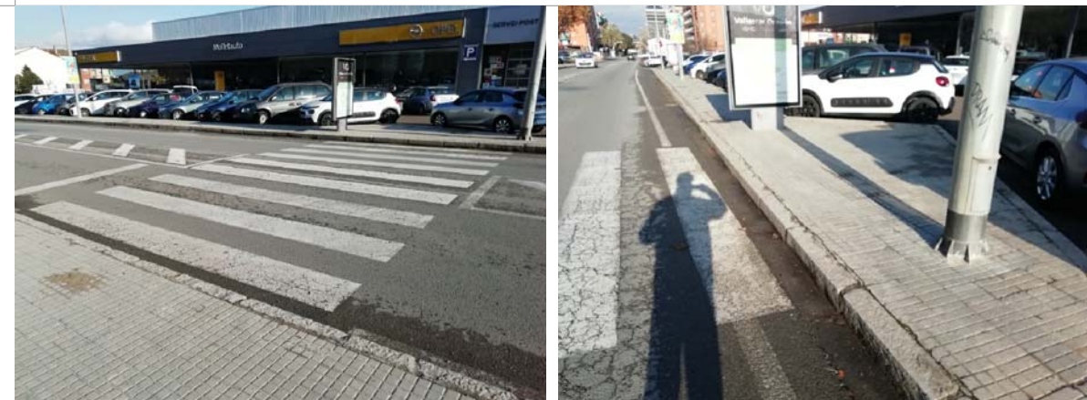
FOTOGRAFIA ÀMBIT ACTUACIÓ
