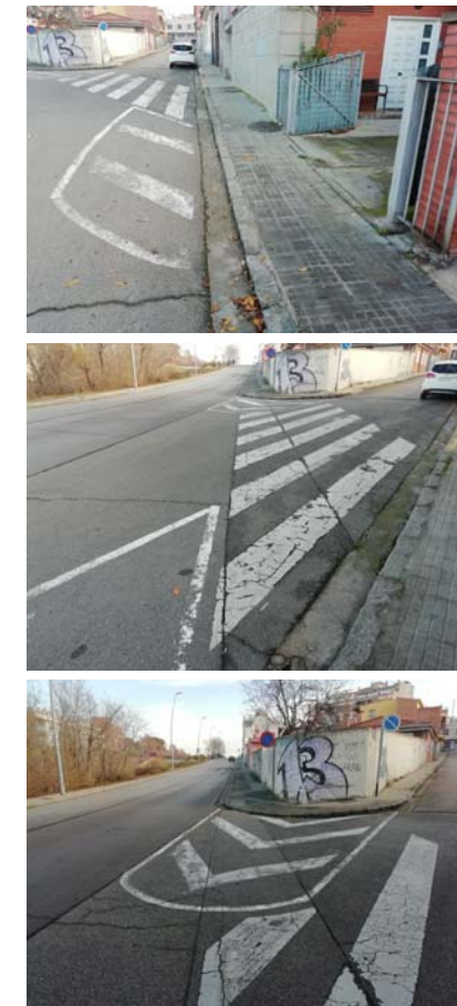
FOTOGRAFIA ÀMBIT ACTUACIÓ
