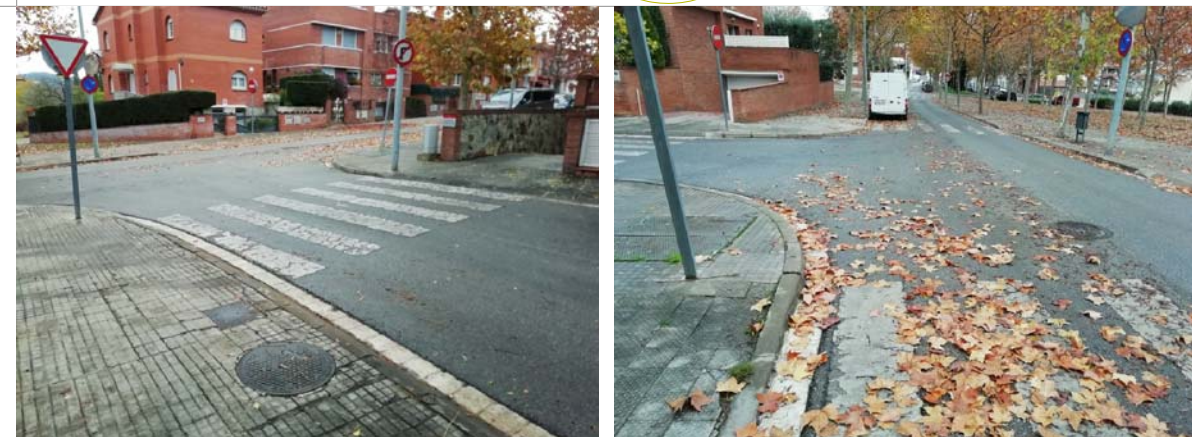
FOTOGRAFIA ÀMBIT ACTUACIÓ
