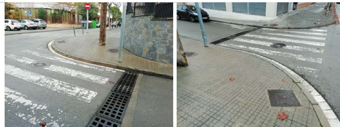
FOTOGRAFIA ÀMBIT ACTUACIÓ
