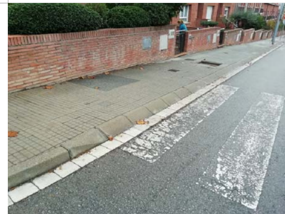
FOTOGRAFIA ÀMBIT ACTUACIÓ
