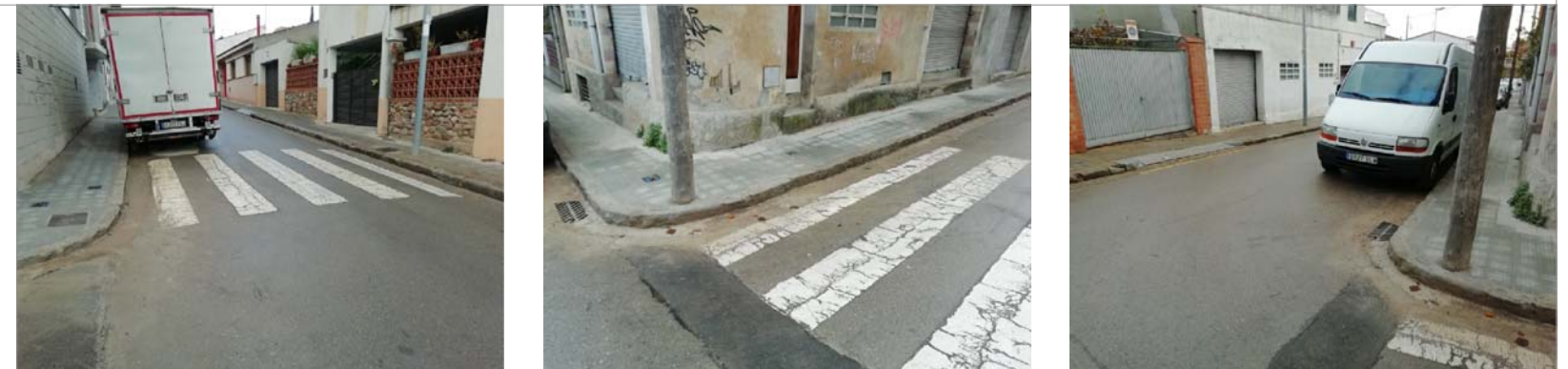
FOTOGRAFIA ÀMBIT ACTUACIÓ
