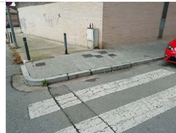
FOTOGRAFIA ÀMBIT ACTUACIÓ
