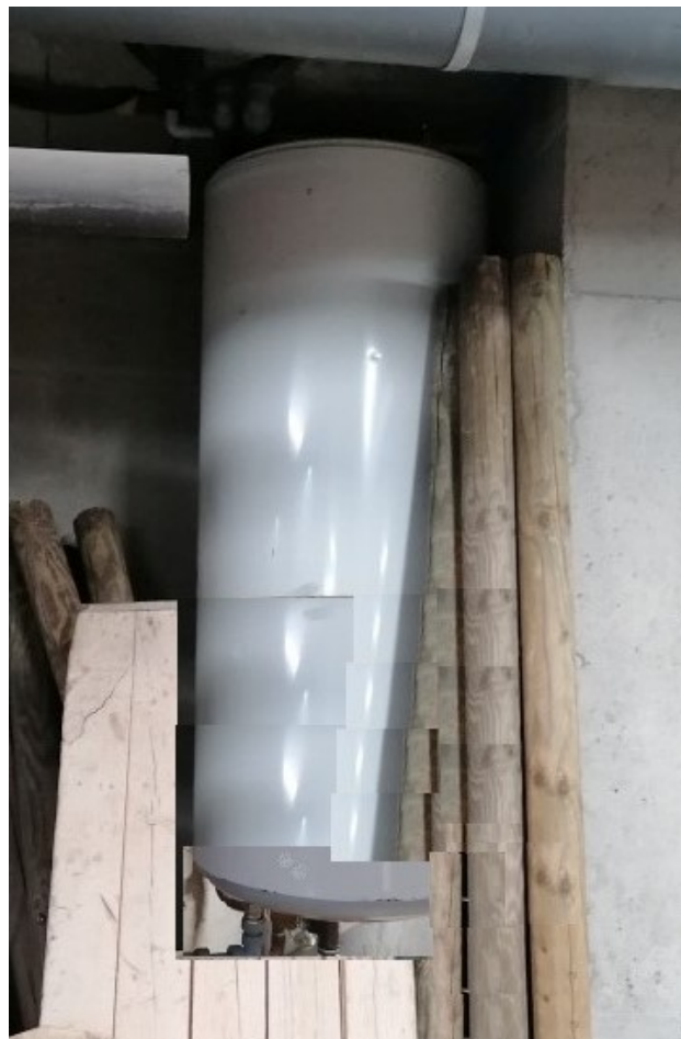
Fotografia 7. Vista estat actual Soterrani (instal·lació ACS)
