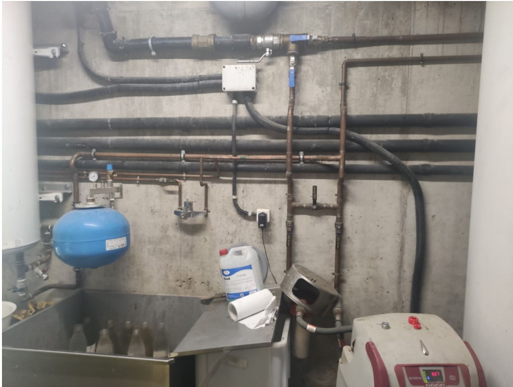
Fotografia 6. Vista estat actual Soterrani (instal·lació ACS )
