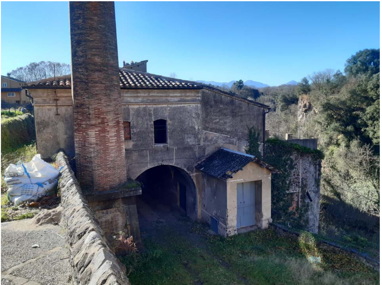
FOTOGRAFIA 1: vista façana nord-est.
