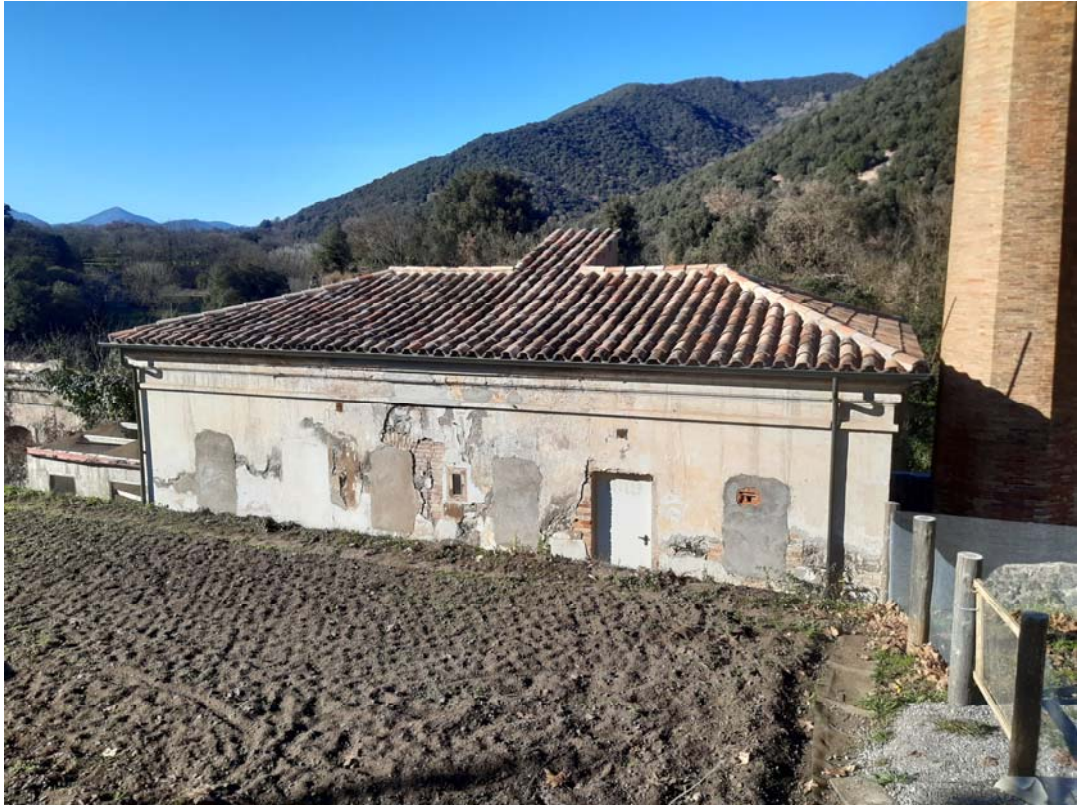
FOTOGRAFIA 2: vista façana sud-est (accés) .
