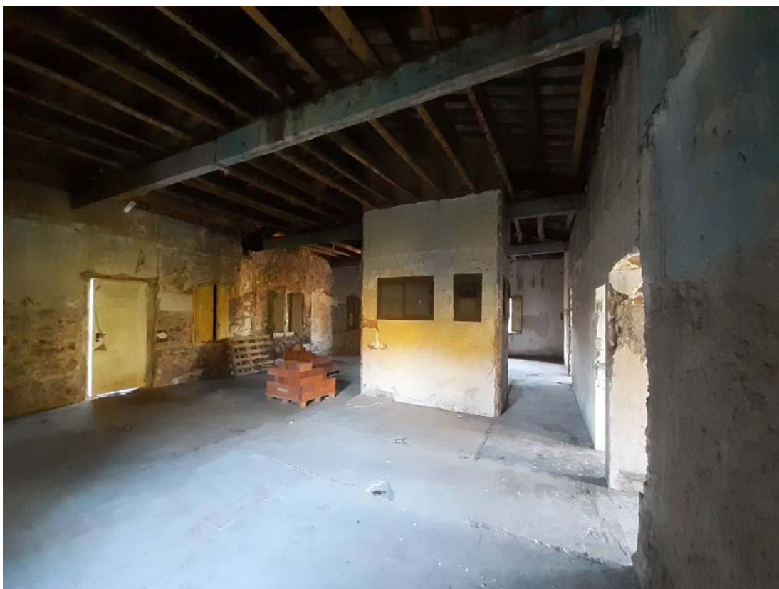
FOTOGRAFIA 5: Vista interior sala 1.
