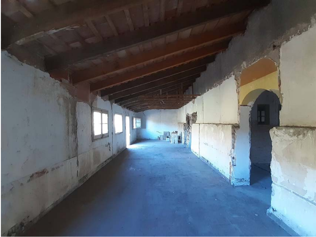
FOTOGRAFIA 6: Vista interior sala 2.
