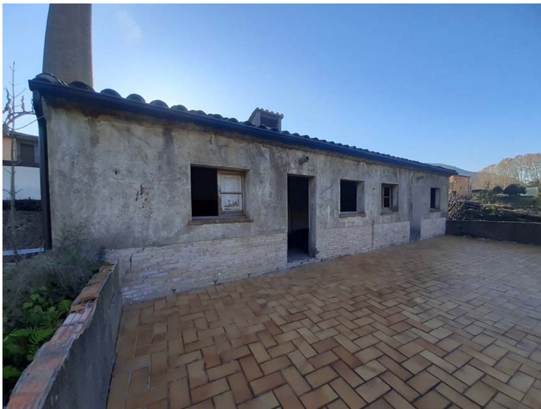
FOTOGRAFIA 4: Vista façana terrassa (nord-oest).
