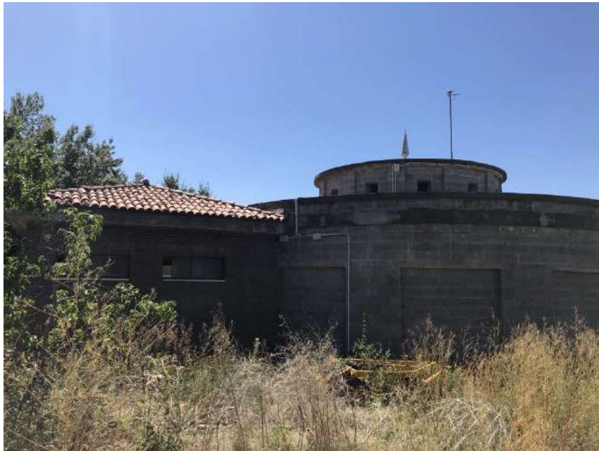
Imatge 6. Vista general del dipòsit i caseta de bombes de Sant Serni
