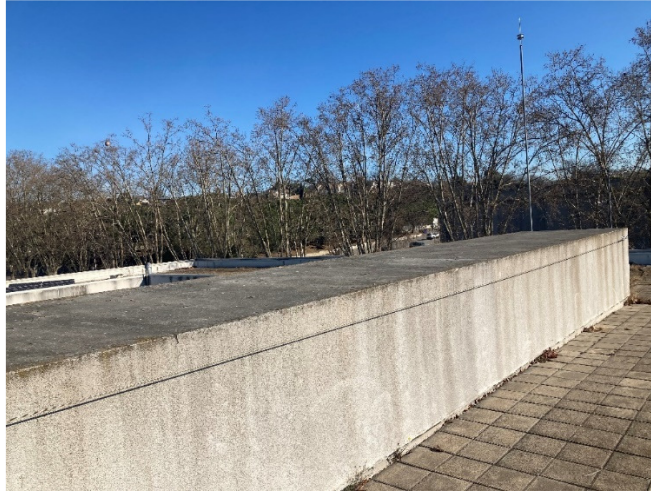
Foto 6. Vista superior coberta cos sobresortint (instal·lació coplanar) i pas sud entre cobertes (instal·lació suports 15° amb llast)
