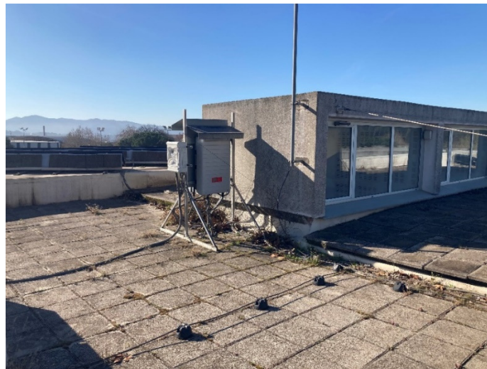
Foto 4. Vista nord cos sobresortint coberta tipus 2 (coplanar) amb detalla estructura i equips instal·lació fotovoltaica existent i descarregador parallamps
