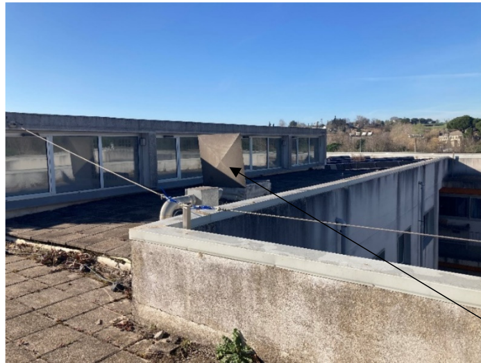
Foto 3. Línies de vida i cos sobresortint coberta amb instal·lació tipus 2 (coplanar) Punt accés a coberta
