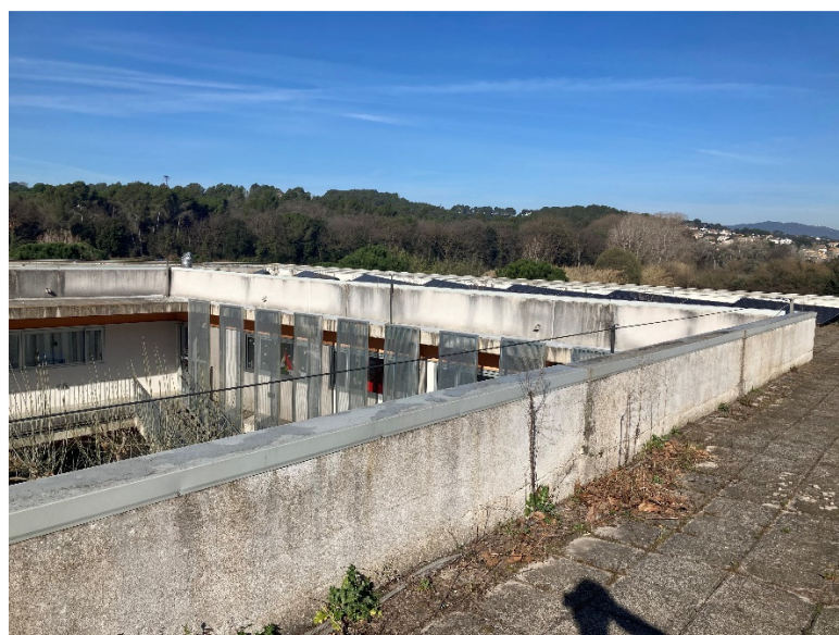
Foto 2. Vista lateral coberta 1 amb detall ubicació línia de vida lateral amb pati exterior
