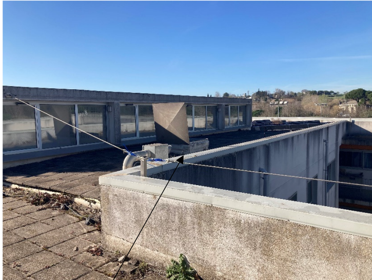
Punt accés a coberta des d'escala retràctil en planta inferior
