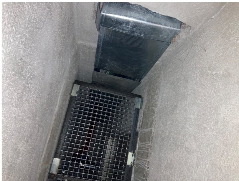
Foto 8. Espai de construcció comunicació planta coberta amb sala quadre general.
