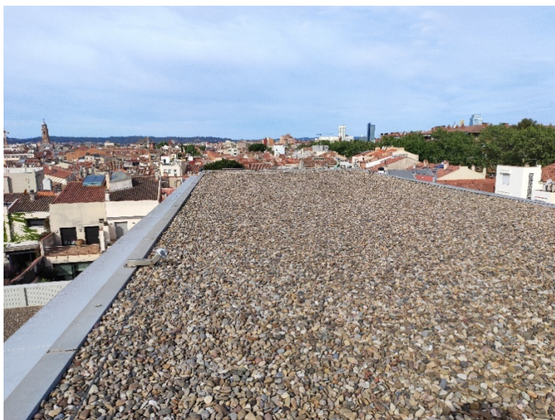
Il·lustració 2: Coberta superior plana i recoberta de grava.
