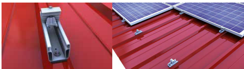
Il·lustració 5. Estructura de suport a la coberta
