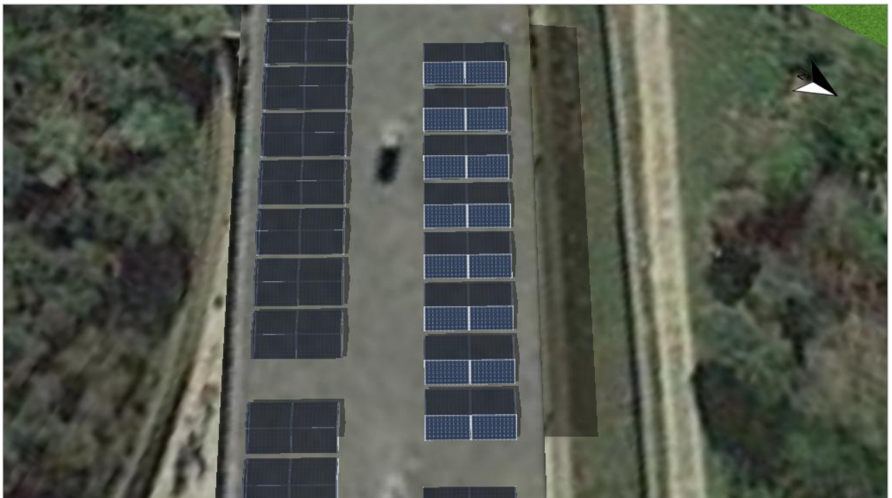
Figura: 6. Superficie fotovoltaica - 3
