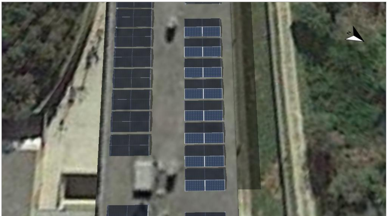
Figura: 3. Superficie fotovoltaica - 2
