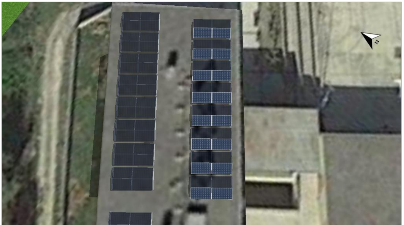
Figura: 8. Superficie fotovoltaica - 4
