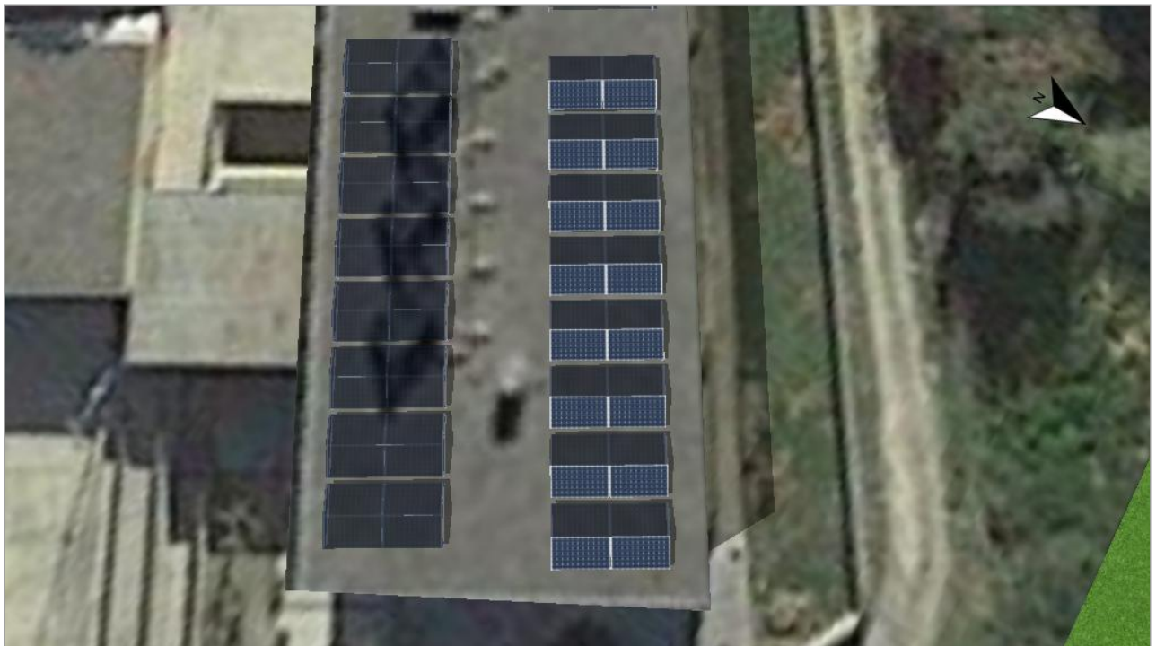
Figura: 1. Superficie fotovoltaica - 1
