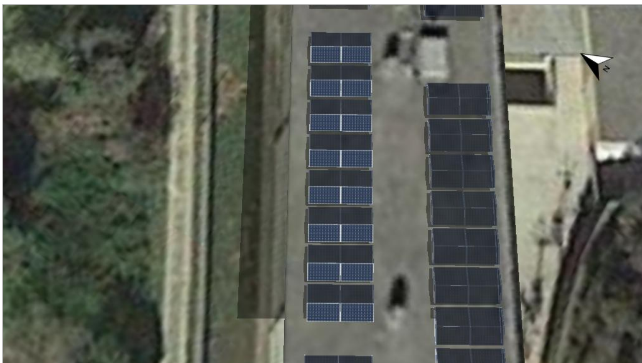
Figura: 4. Superficie fotovoltaica - 2
