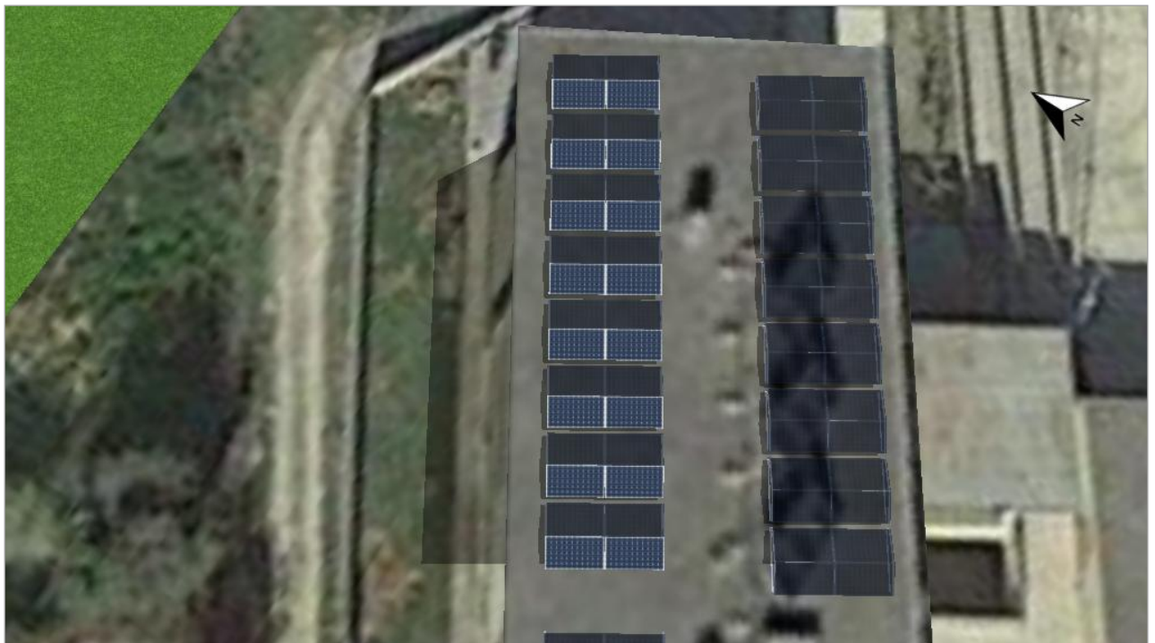
Figura: 2. Superficie fotovoltaica - 1
