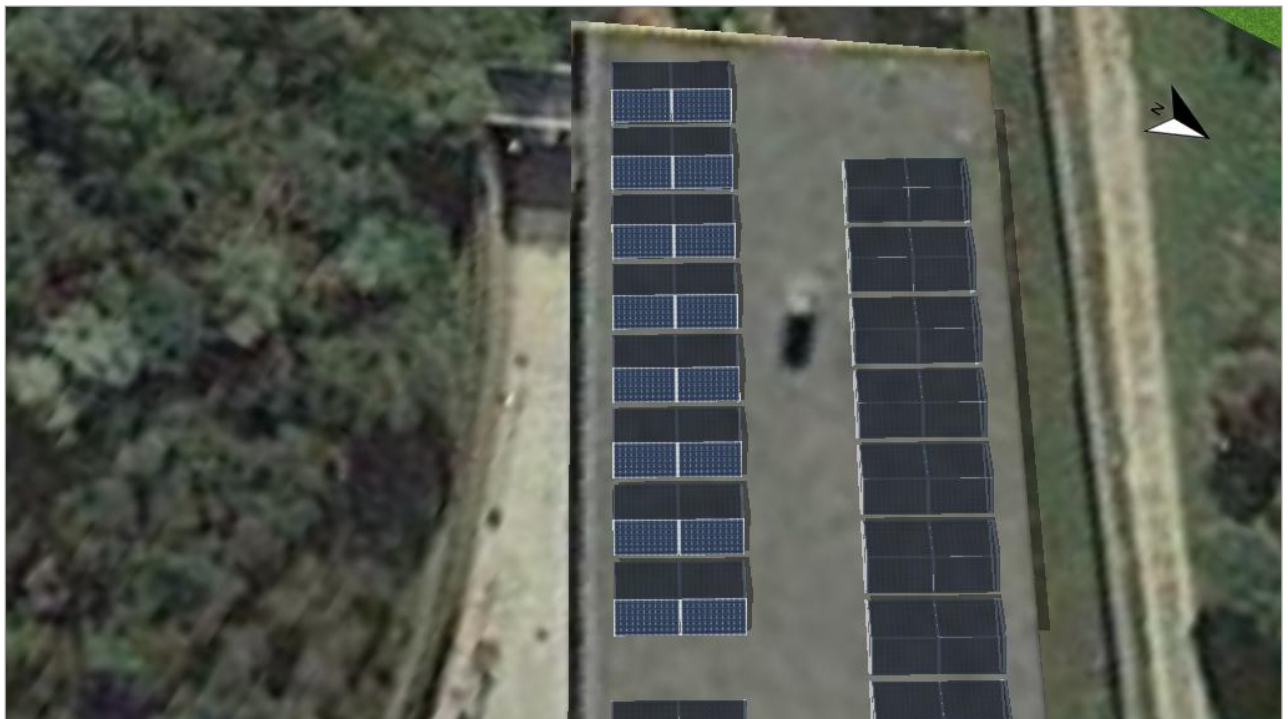
Figura: 11. Superficie fotovoltaica - 6
