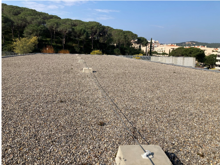
Foto 1. Tram de coberta ubicació panells solars amb detall ubicació línia de vida
