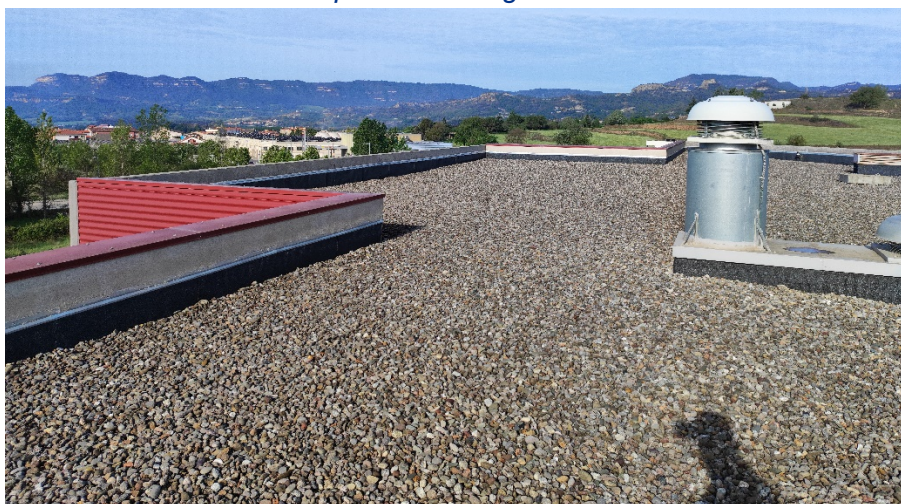
Il·lustració 2: Coberta de grava.
