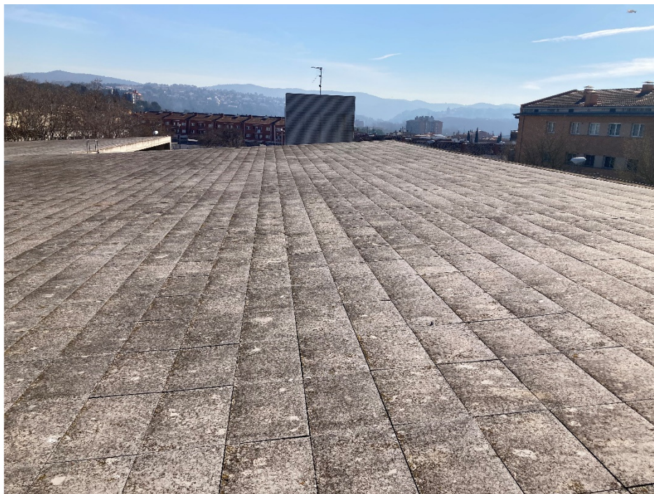
Foto 2. Vista general punt inici coberta façana est
