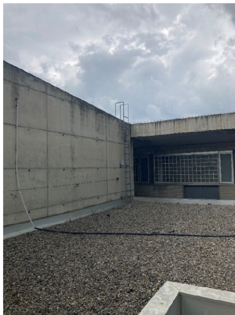
Escala accés a coberta objecte instal·lació
