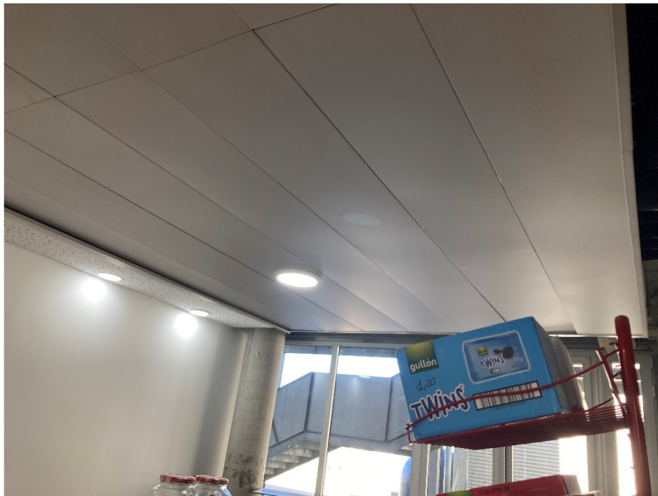
Foto 10. Fals sostre cantina
