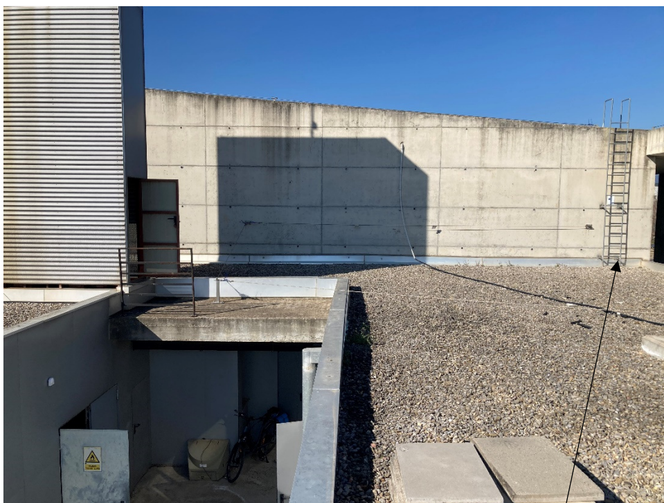
Foto 5. Vista façana est de coberta
