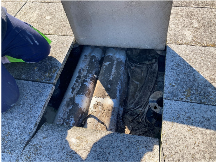
Foto 3. Detall junta dilatació
