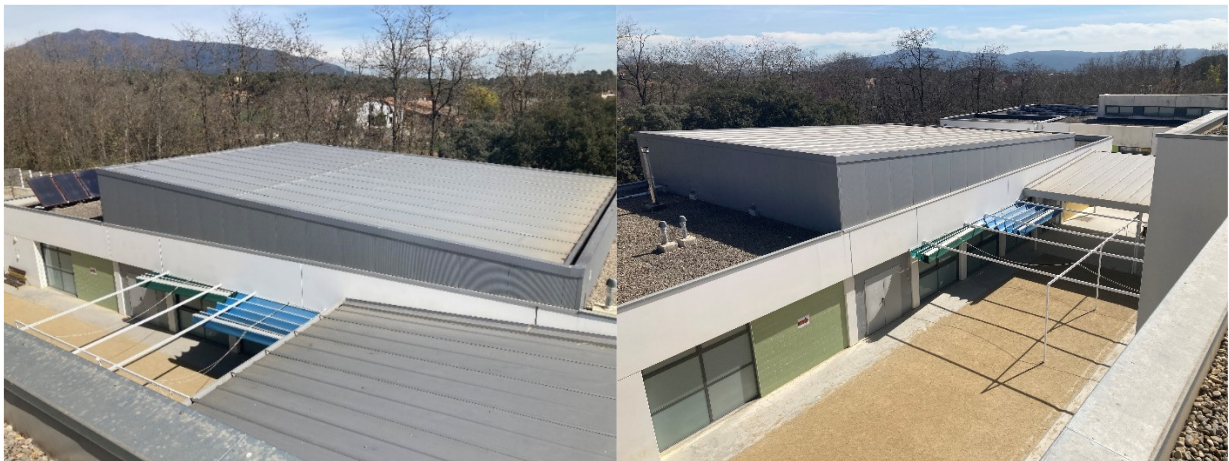
Foto 4. Vista general coberta sandvitx
