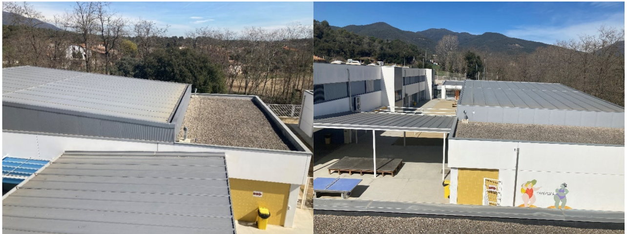
Foto 3. Vista lateral entrega coberta 2 i 3 amb detall ubicació línia de vida central en C2
