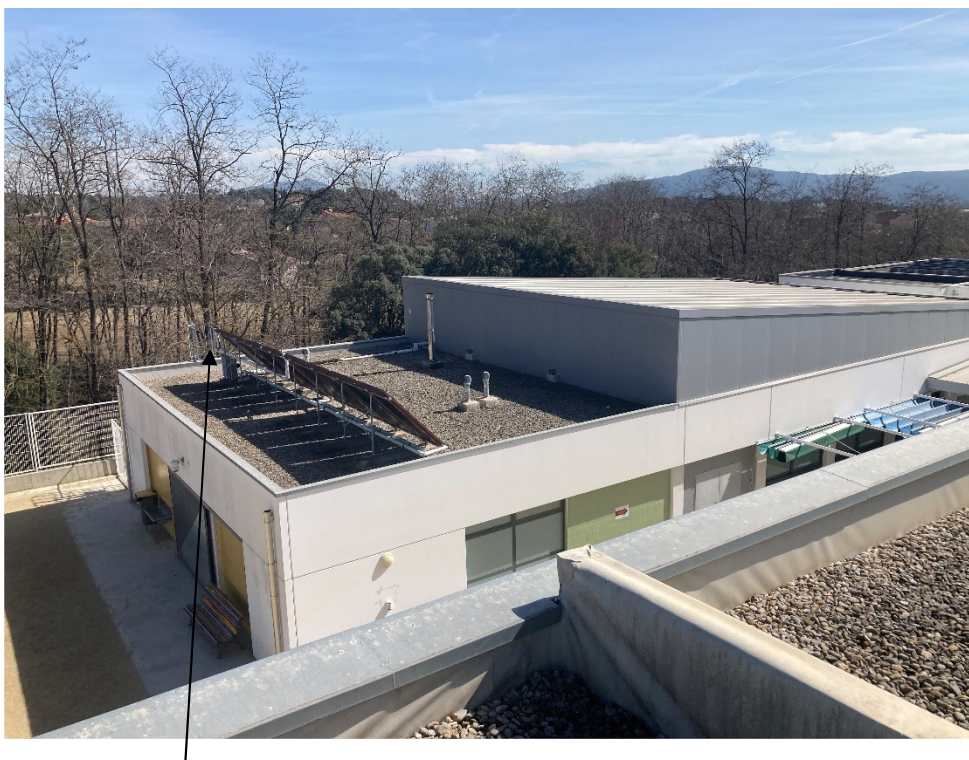
Escala de seguretat accés coberta plana nord edifici gimnàs
