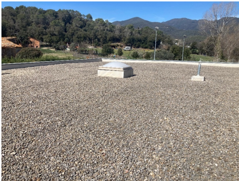
Foto 2. Vista nord de coberta ubicació panells solars amb detall ubicació línia de vida central
