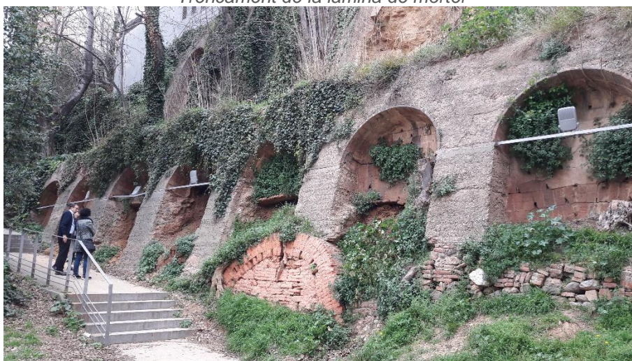
Nivell inferior del mur
