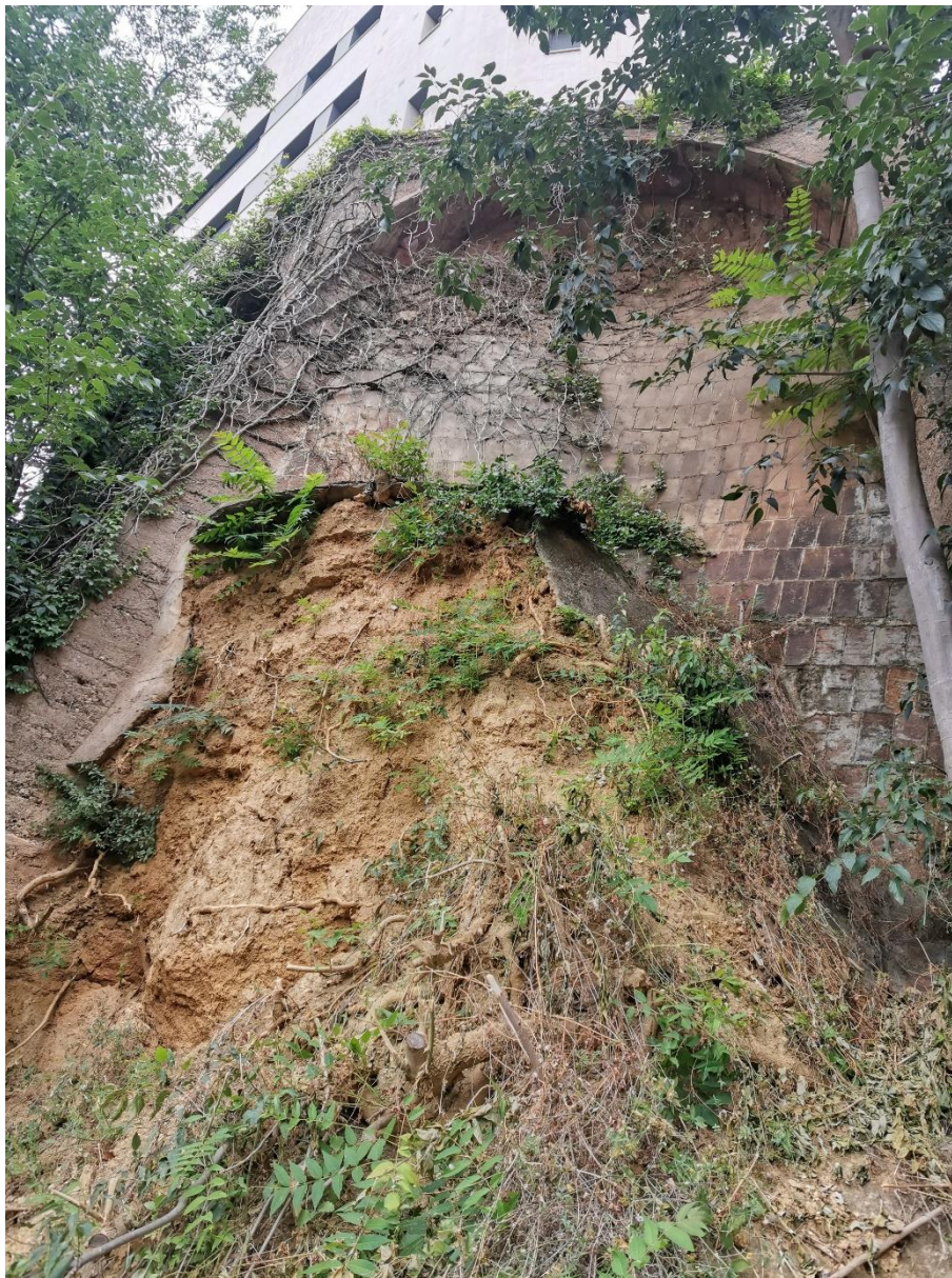
Trencament de la làmina de morter
