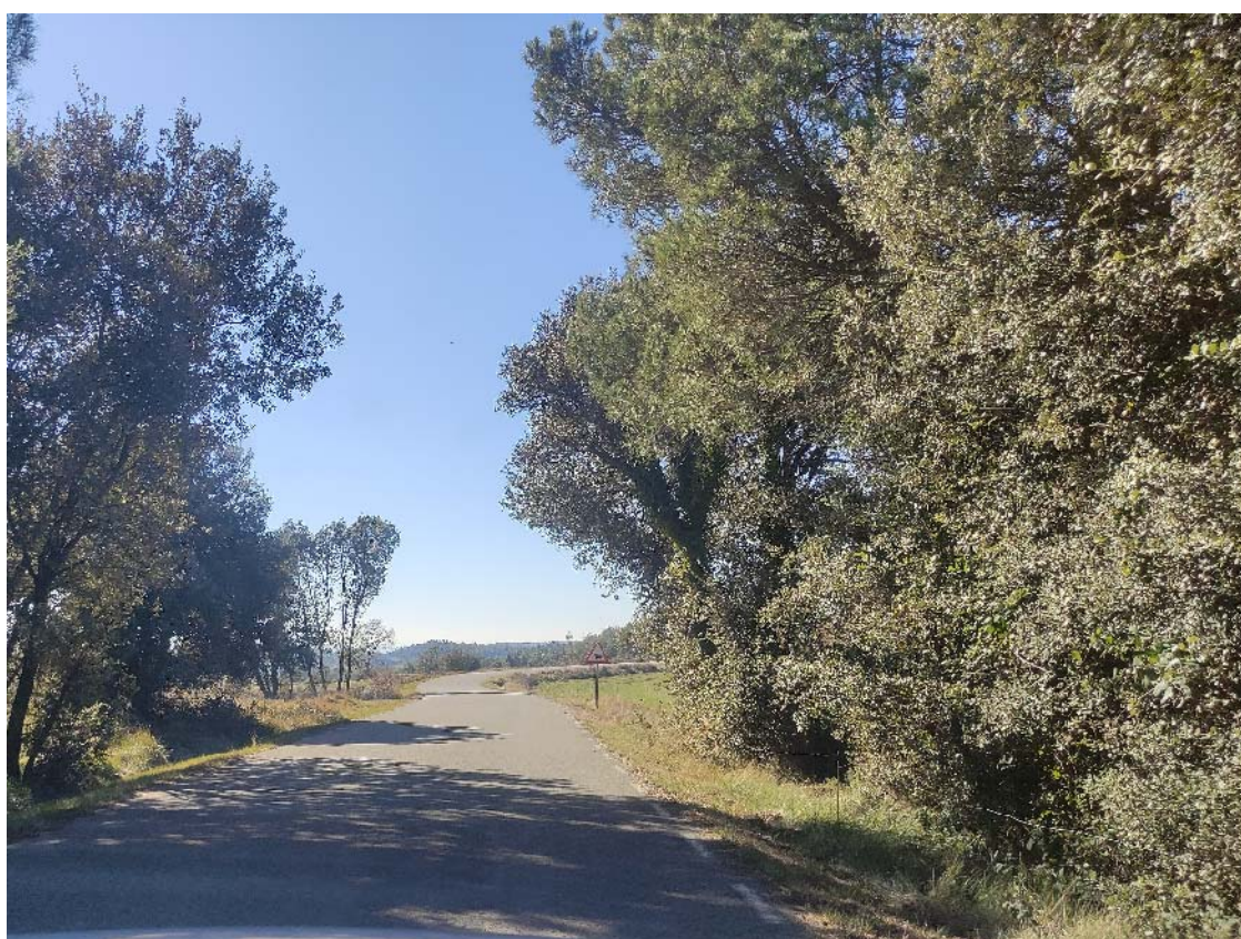
Soterrament línia Els Casals fins a Salvans
