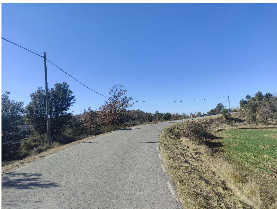
Soterrament línia Els Casals fins a Salvans
