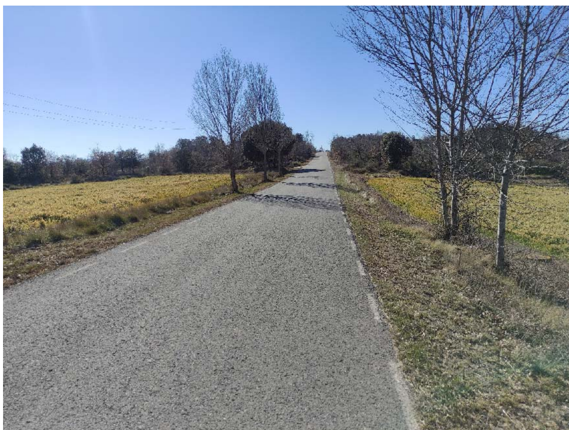
Soterrament línia Els Casals fins a Salvans
