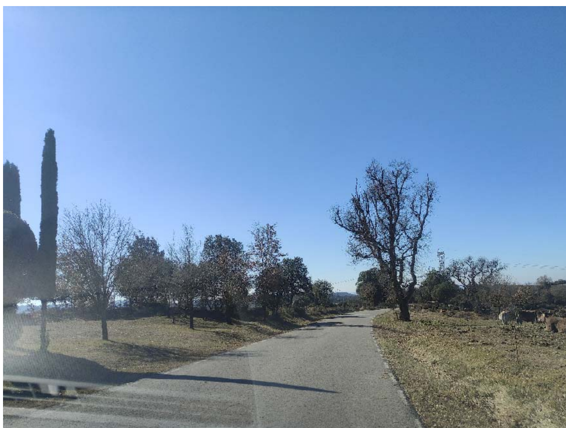
Soterrament línia Els Casals fins a Salvans
