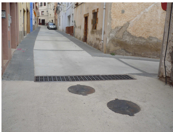
Foto 10: vista del límit del projecte. S'observen les tapes dels pous d registre de pluvials i residuals, punts de connexió amb les xarxes existents
