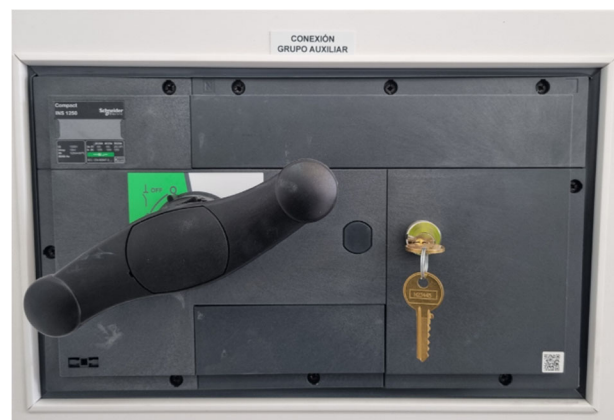
Quadre General BT (Interruptor Grup electrogen)
