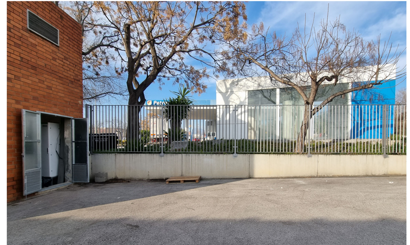
Façana actual del centre de transformació
