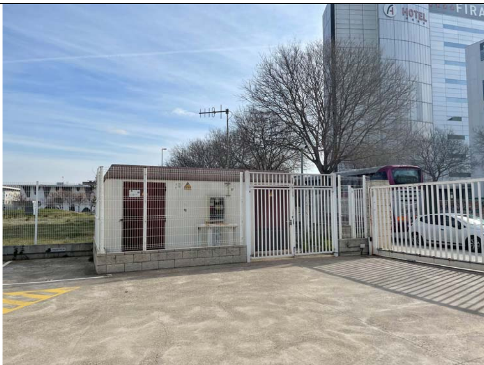
Entorn: vista exterior de la estació transformadora
