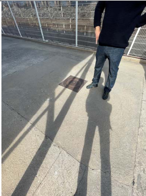
Entorn: vista exterior dipòsits gasoil enterrats
