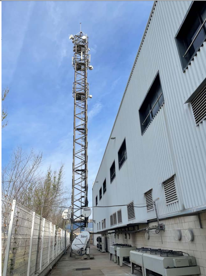
Entorn: vista exterior torre de telecomunicacions
