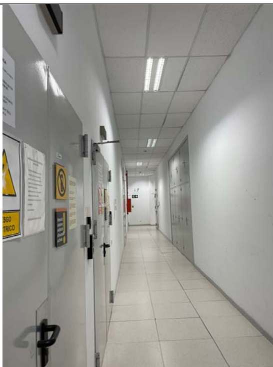
Edifici: vista interior passadís planta baixa
