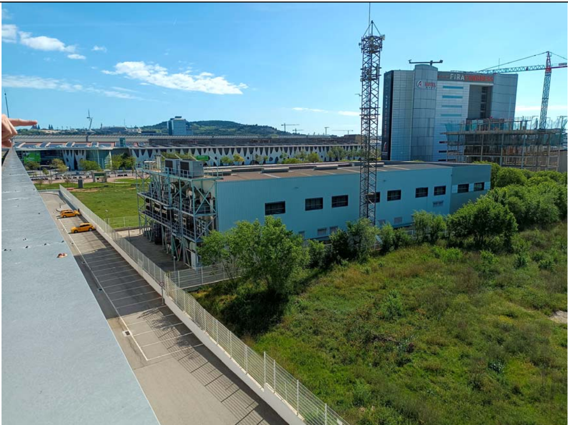
Edifici: Vista exterior general
