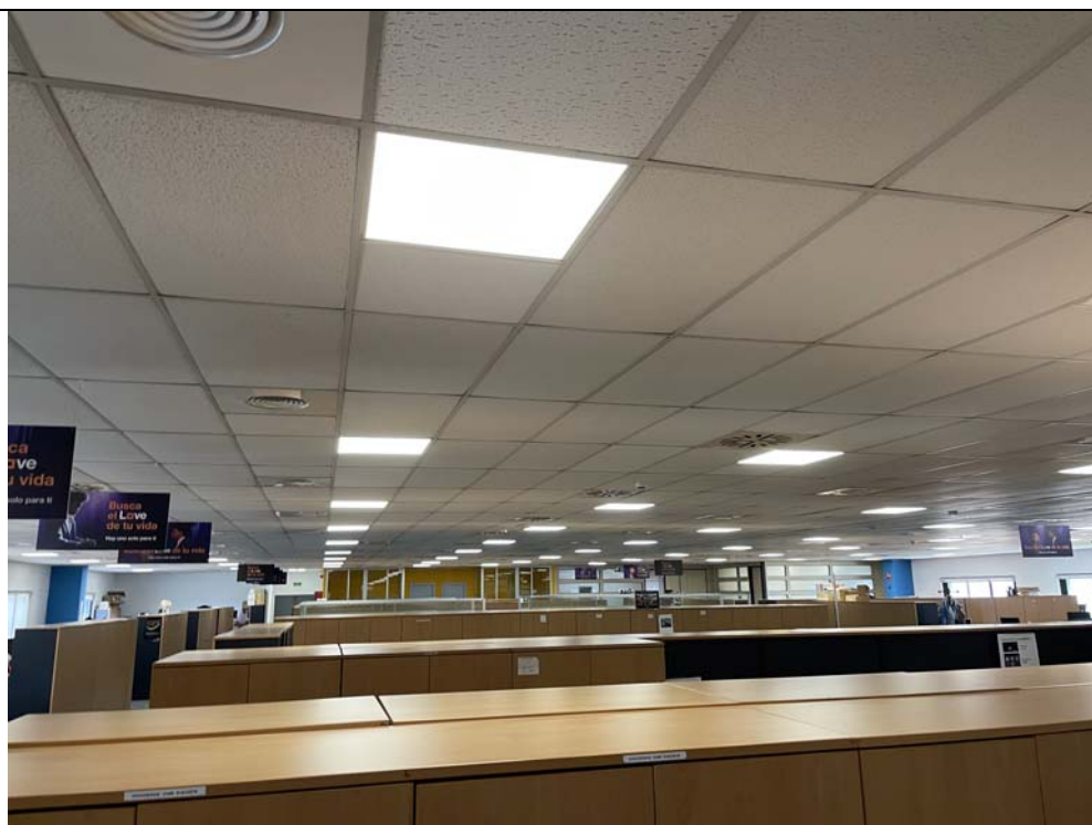
Edifici: vista interior oficines planta primera
