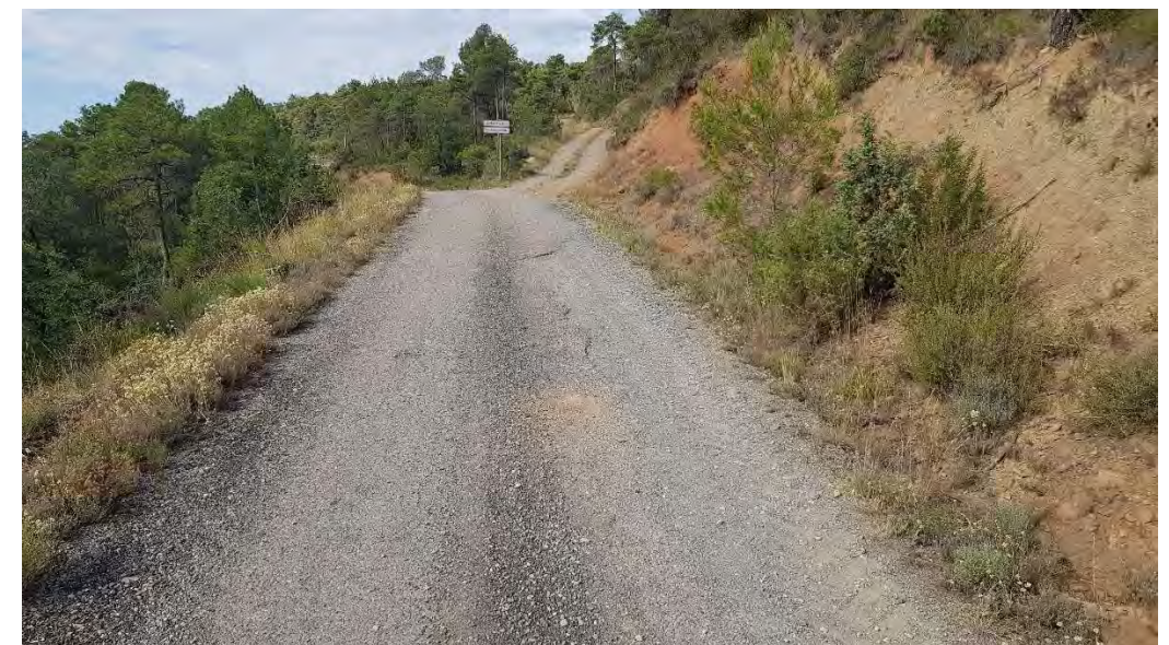
Foto 17.- pK 1+440 Camí d'accès a Bellfort (Coord. UTM X=348.839 Y=4.651.543)
