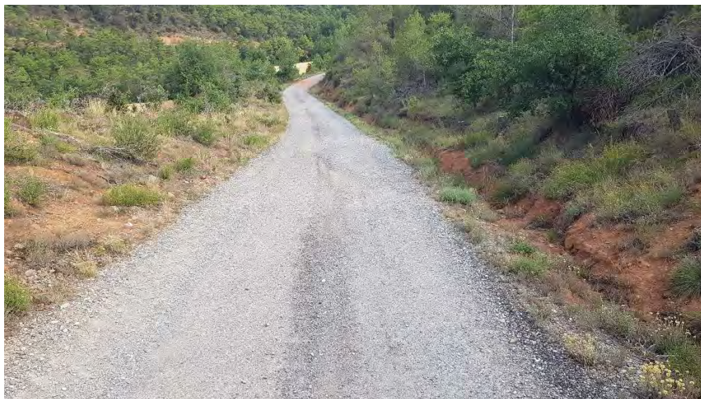
Foto 14.- pK 1+100 Camí d'accès a Bellfort (Coord. UTM X=348.937 Y=4.651.323)
