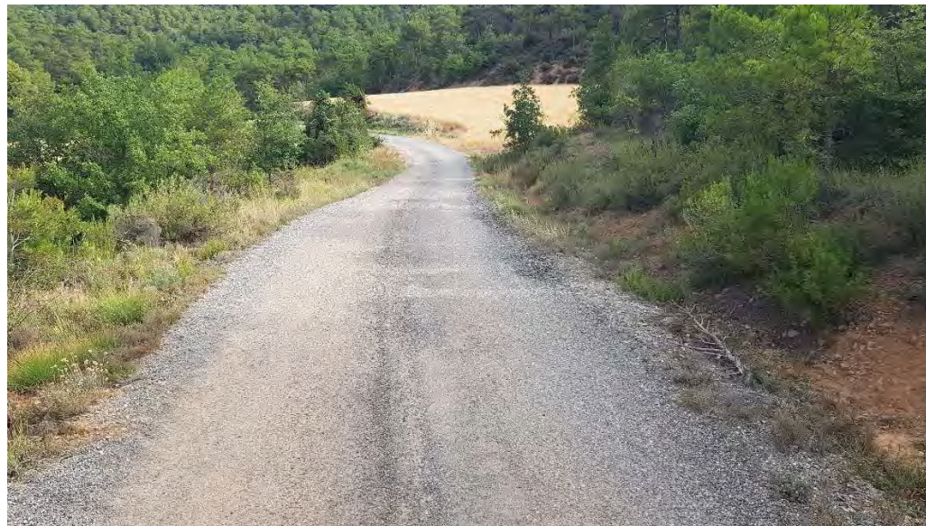
Foto 15.- pK 1+220 Camí d'accès a Bellfort (Coord. UTM X=348.910 Y=4.651.439)
