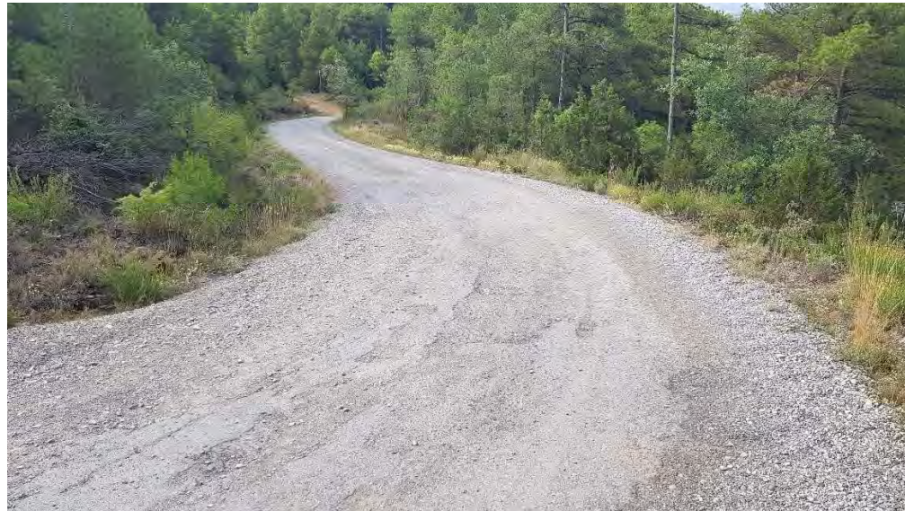
Foto 25.- pK 2+380 Camí d'accès a Bellfort (Coord. UTM X=348.310 Y=4.651.218)
