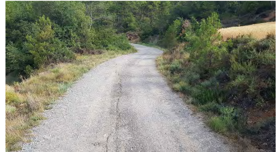
Foto 16.- pK 1+300 Camí d'accès a Bellfort (Coord. UTM X=348.898 Y=4.651.515)
