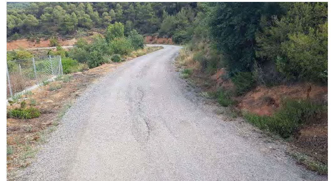
Foto 11.- pK 0+820 Camí d'accès a Bellfort (Coord. UTM X=349.080 Y=4.651.139)
