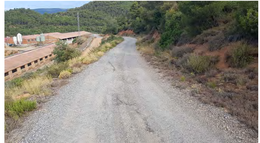
Foto 10.- pK 0+740 Camí d'accès a Bellfort (Coord. UTM X=349.139 Y=4.651.086)
