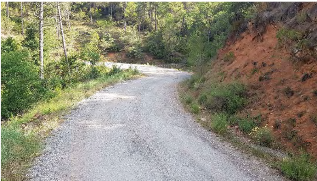
Foto 26.- pK 2+540 Camí d'accès a Bellfort (Coord. UTM X=348.268 Y=4.651.121)
