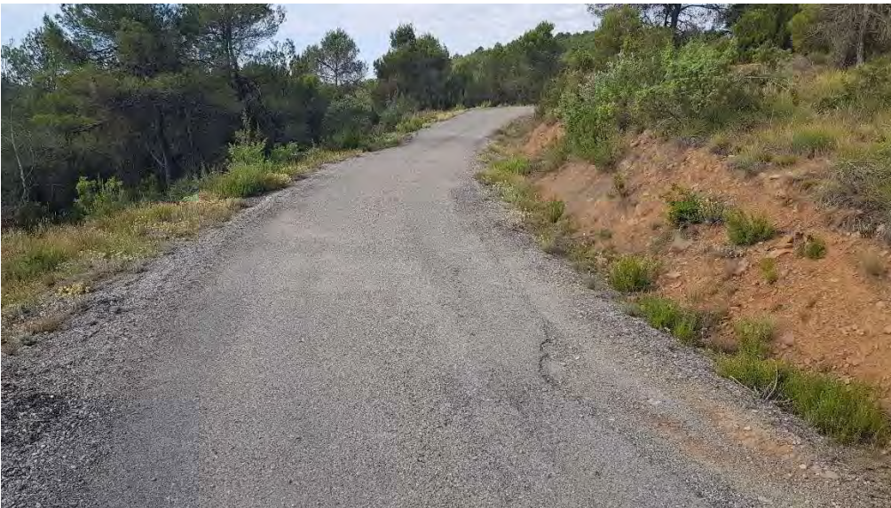
Foto 21.- pK 1+900 Camí d'accès a Bellfort (Coord. UTM X=348.732 Y=4.651.167)
