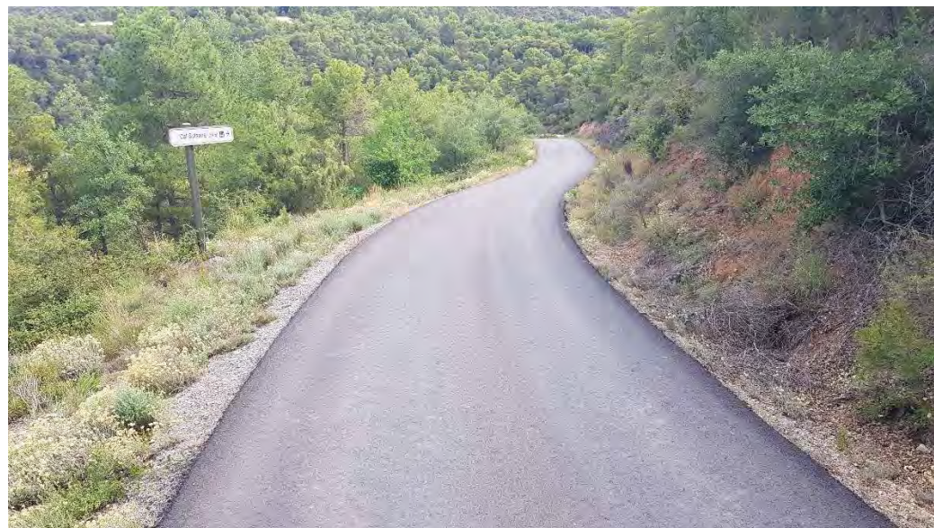
Foto 3.- pK 0+100 Camí d'accès a Bellfort (Coord. UTM X=349.361 Y=4.650.844)
