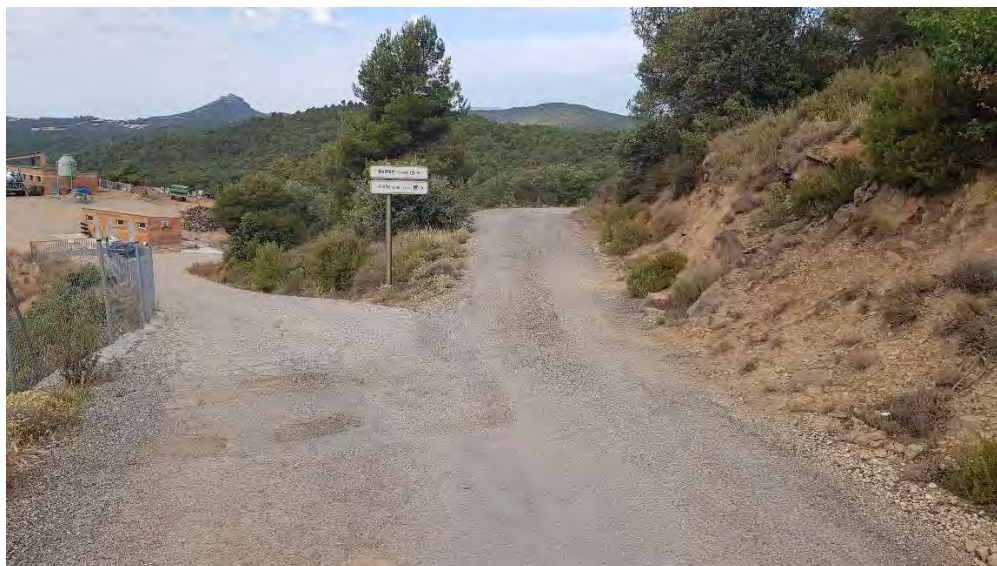
Foto 9.- pK 0+700 Camí d'accès a Bellfort (Coord. UTM X=349.178 Y=4.651.085)
