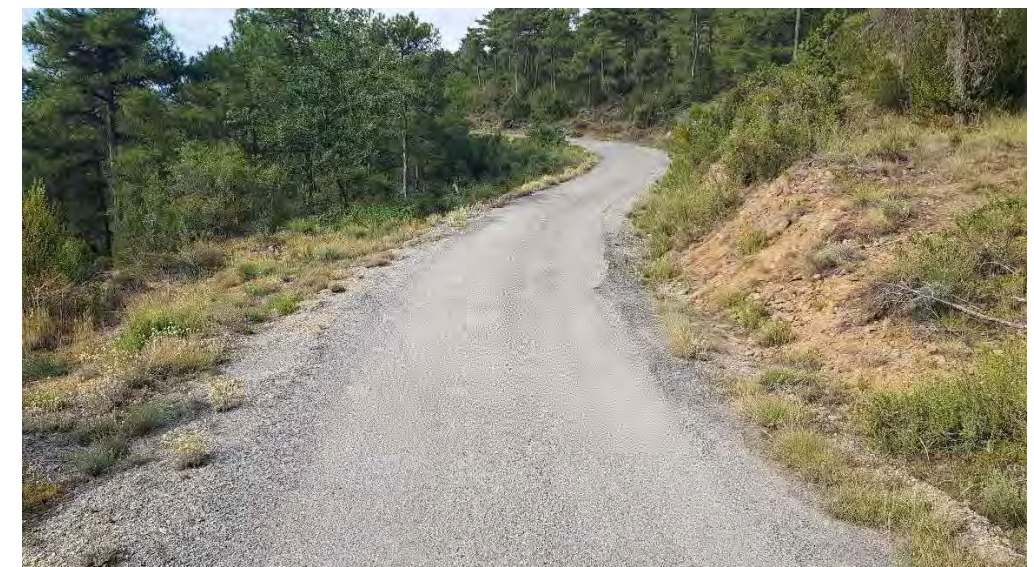
Foto 18.- pK 1+520 Camí d'accès a Bellfort (Coord. UTM X=348.806 Y=4.651.473)
