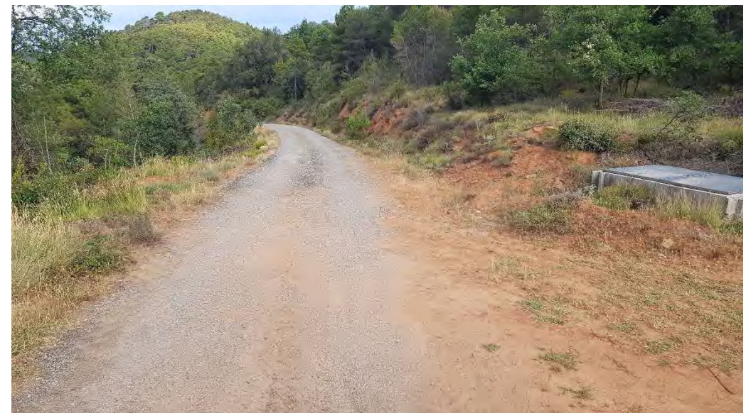
Foto 23.- pK 2+120 Camí d'accès a Bellfort (Coord. UTM X=348.535 Y=4.651.134)
