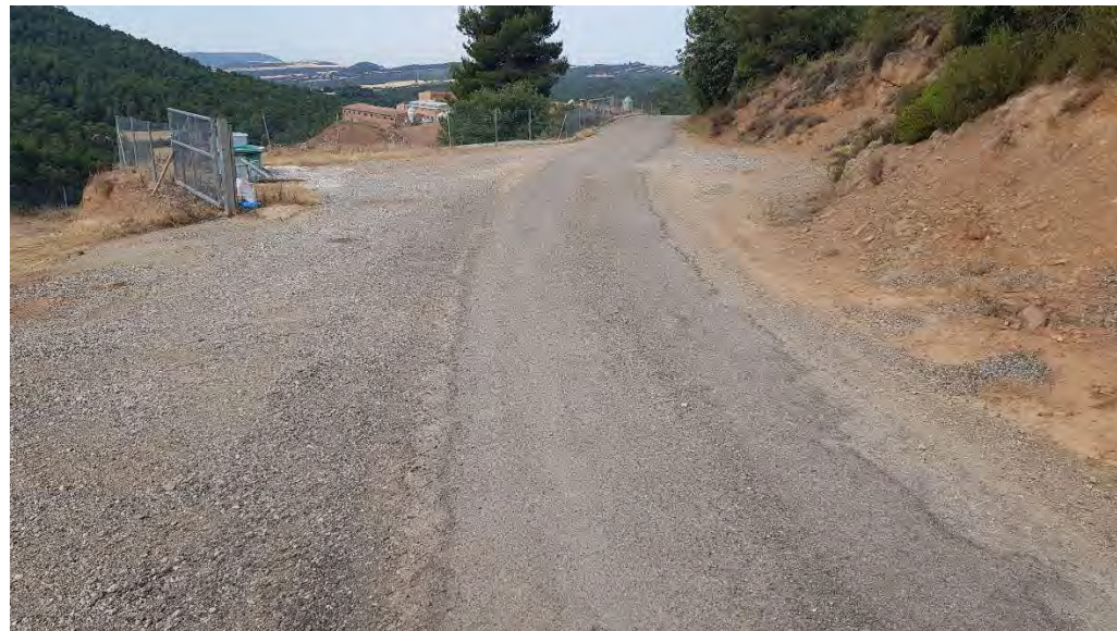
Foto 8.- pK 0+620 Camí d'accès a Bellfort (Coord. UTM X=349.244 Y=4.651.127)
