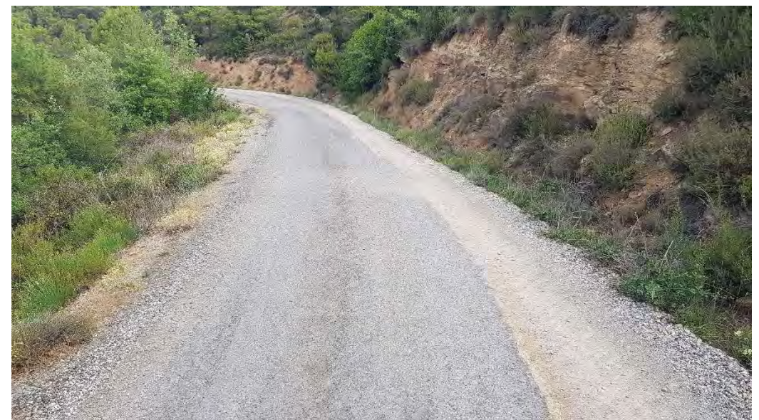
Foto 5.- pK 0+300 Camí d'accès a Bellfort (Coord. UTM X=349.454 Y=4.651.016)
