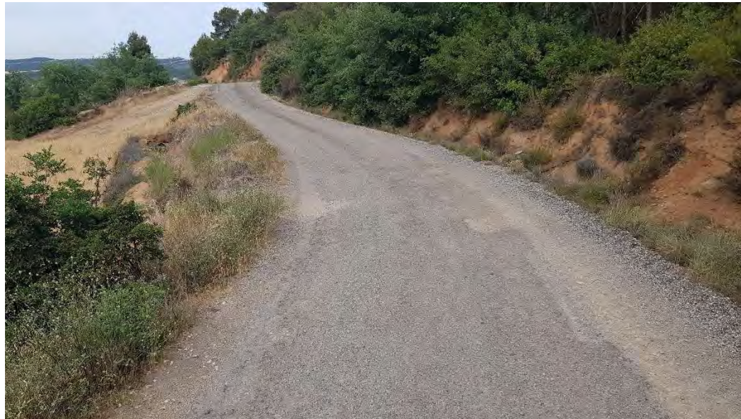
Foto 7.- pK 0+540 Camí d'accès a Bellfort (Coord. UTM X=349.308 Y=4.651.174)
