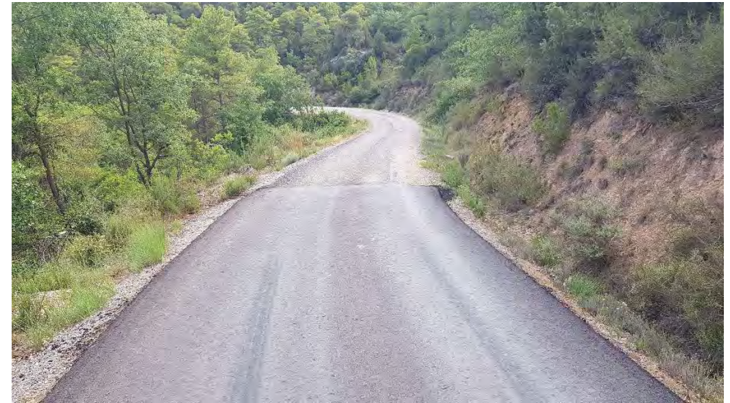
Foto 4.- pK 0+220 Camí d'accès a Bellfort (Coord. UTM X=349.419 Y=4.650.948)
