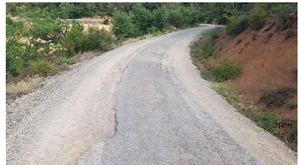
Foto 6.- pK 0+420 Camí d'accès a Bellfort (Coord. UTM X=349.369 Y=4.651.093)
