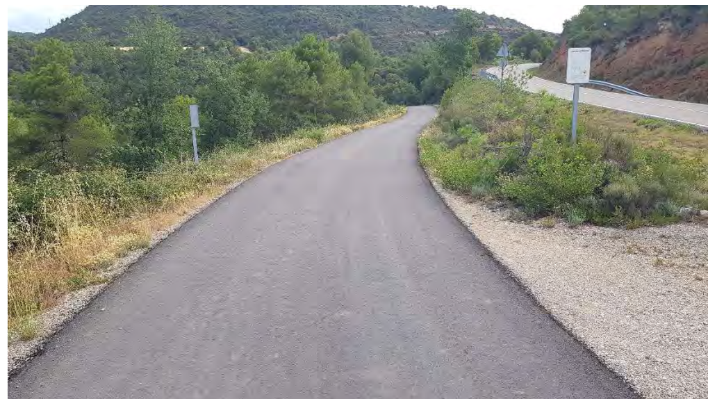
Foto 2.- pK 0+003 Camí d'accès a Bellfort (Coord. UTM X=349.314 Y=4.650.762)
