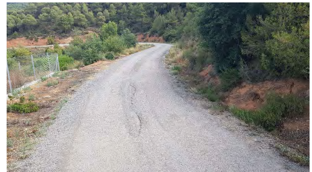
Foto 12.- pK 0+900 Camí d'accès a Bellfort (Coord. UTM X=349.019 Y=4.651.185)
