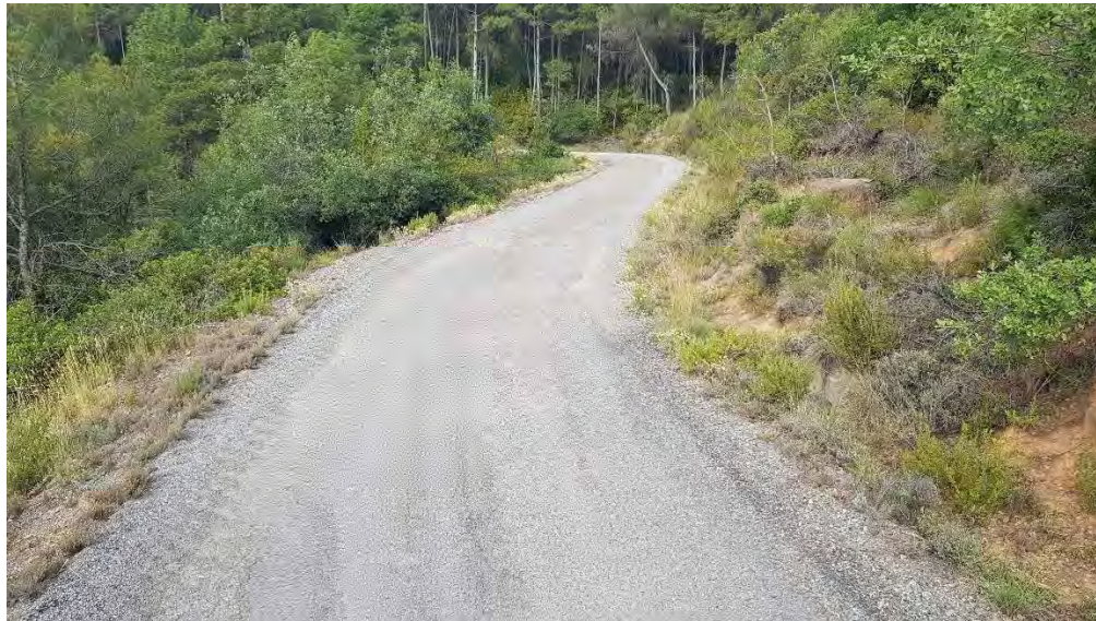
Foto 19.- pK 1+640 Camí d'accès a Bellfort (Coord. UTM X=348.754 Y=4.651.375)
