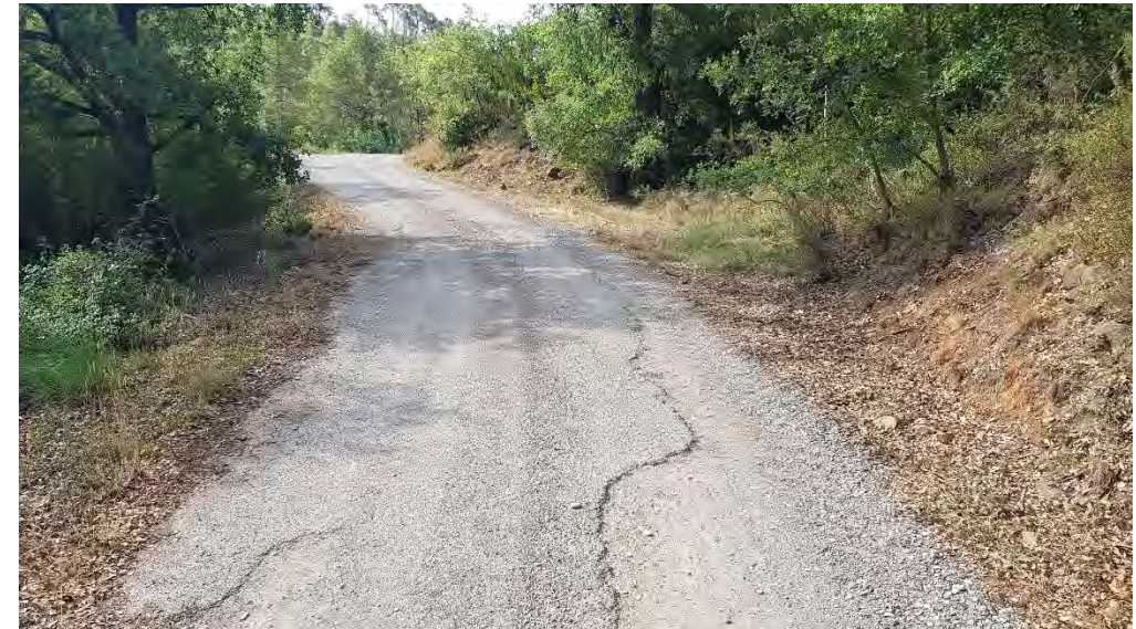
Foto 28.- pK 2+760 Camí d'accès a Bellfort (Coord. UTM X=348.162 Y=4.651.095)
