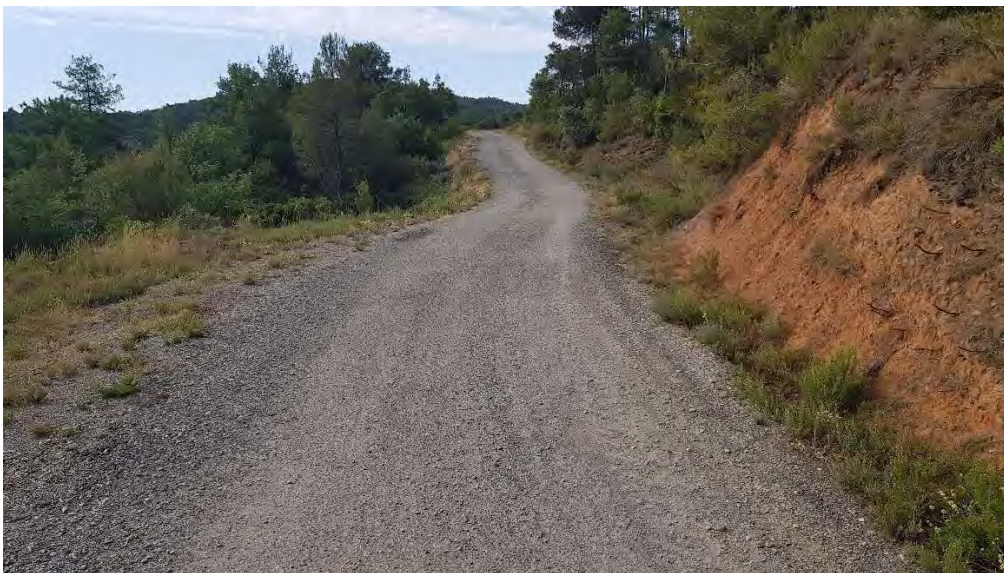
Foto 20.- pK 1+740 Camí d'accès a Bellfort (Coord. UTM X=348.707 Y=4.651.323)
