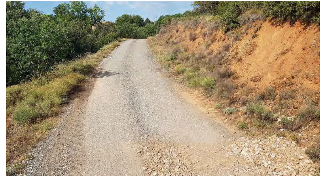
Foto 28.- pK 2+860 Camí d'accès a Bellfort (Coord. UTM X=348.171 Y=4.651.003)
