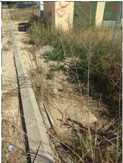
Imatge de la Canonada de reserva de polietilè corrugat Ø63mm existent
