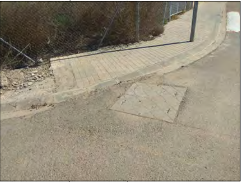
Arqueta tipus H existent
