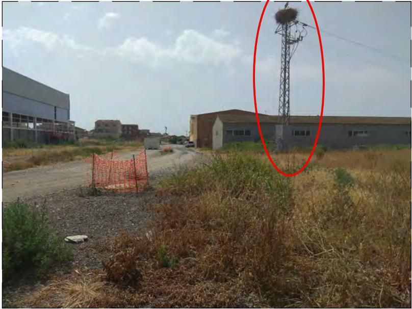
Imatge Torre Elèctrica
