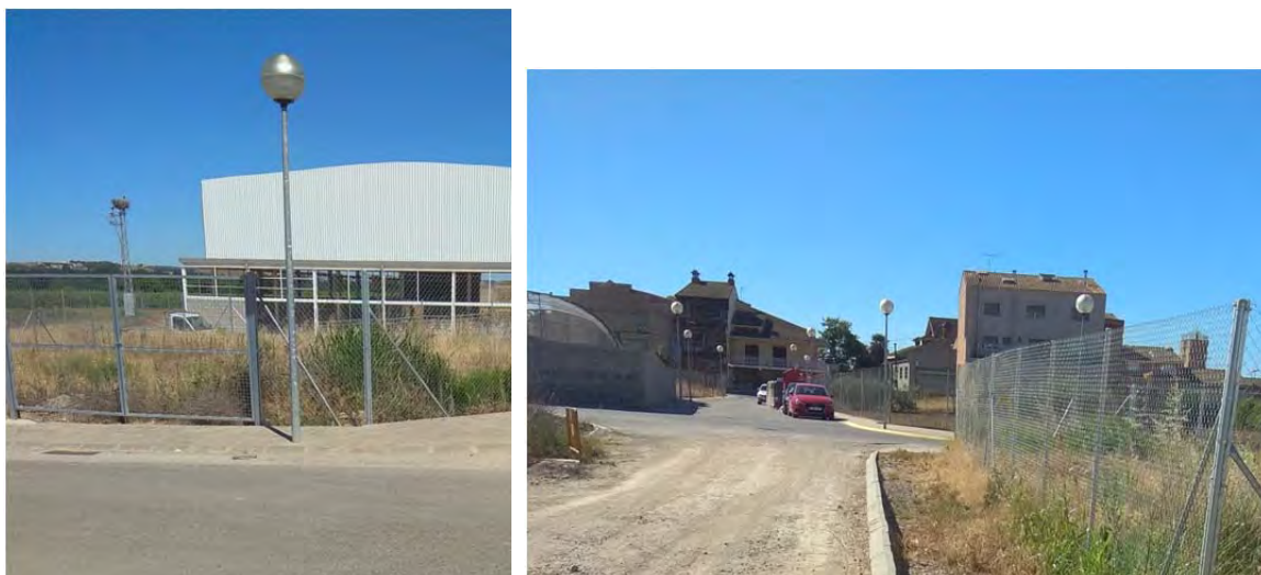
Imatge faroles existents en l'entorn de l'àmbit a urbanitzar
