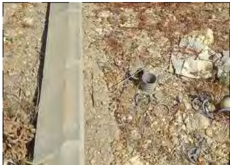
Imatge d'una de les Canonades aèries preparades per la instal·lació de les faroles
