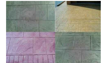
Pavimento de hormigón impreso
