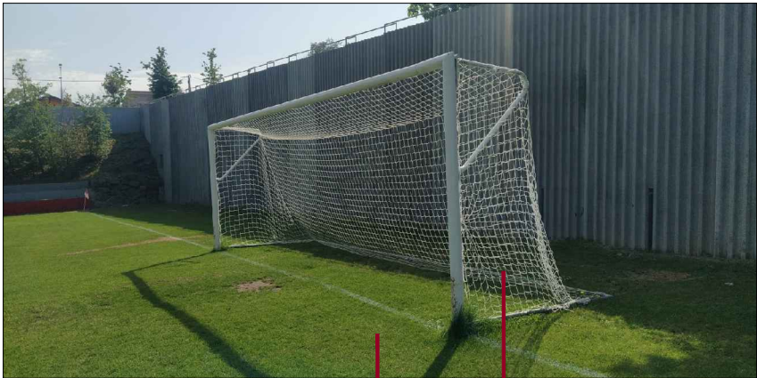
RETIRADA GESPA NATURAL ENDERROC FONAMENTS I RETIRADA PORTERIA F11
