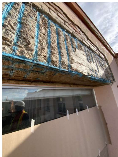
Estat de la jàssera de la llinda de planta segona
