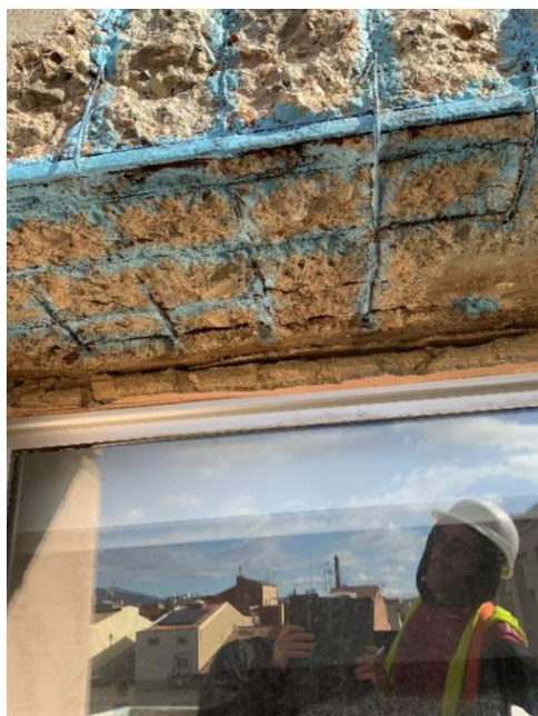
Estat de la jàssera de la llinda de planta segona
