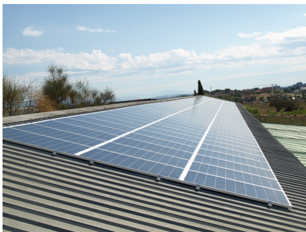
Instal·lació coplanar a coberta de xapa
