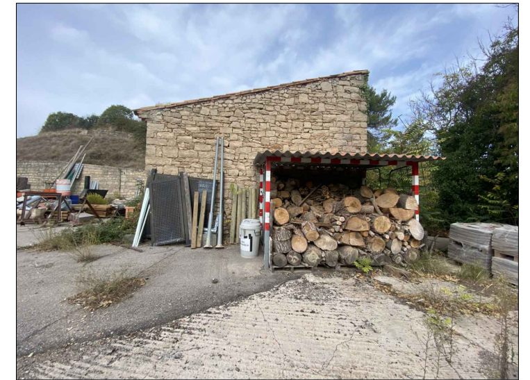
Vista lateral de l'edifici
