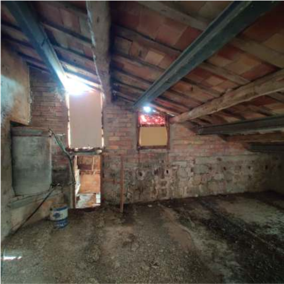
(F2) REPICAT DE GUIX/MORTER EXISTENT
