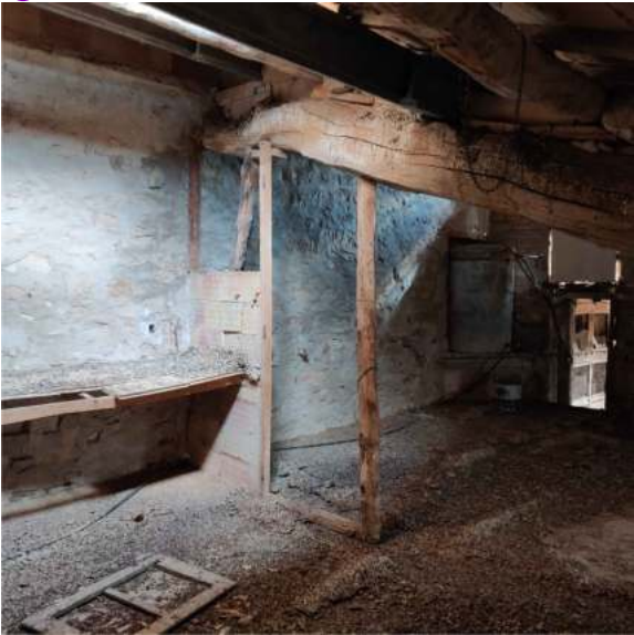
(F2) REPICAT DE GUIX/MORTER EXISTENT
