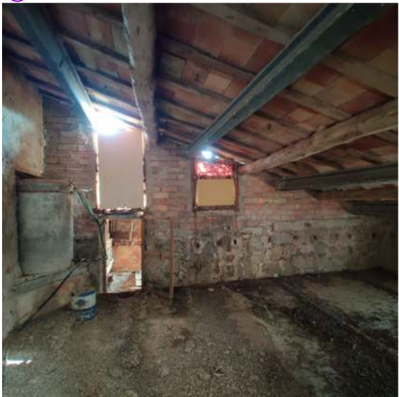
F1 REPICAT DE GUIX/MORTER EXISTENT
