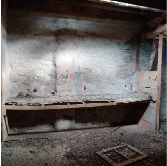
F2 REPICAT DE GUIX/MORTER EXISTENT
