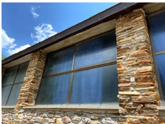
Imatge 06. Estat actual sala polivalent - exterior.
