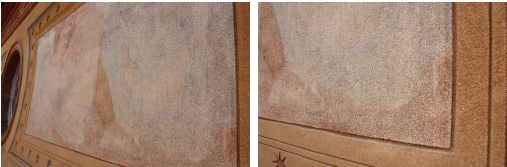
Fotografies detall de la pèrdua del dibuix i el color de les pintures murals per una mala tècnica
