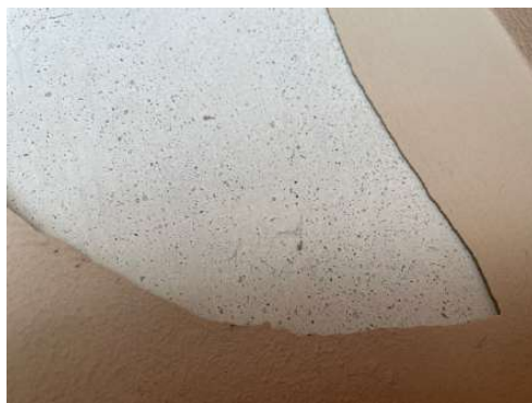
Fotografies detall on s'aprecia el morter M1 aplicat com a lliscat del interior del pòrtic principal
