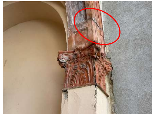
Fotografia detall del desplaçament de la cara anterior del capitell (esq.); detall de la fractura present a la dovella (dret.)
