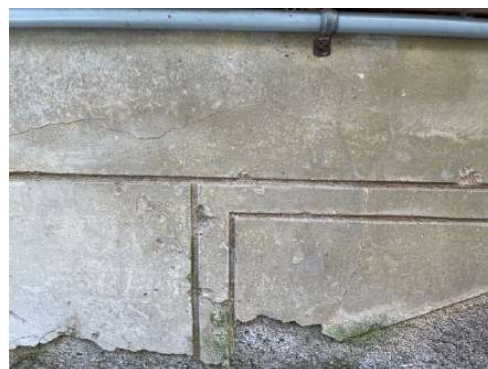
Fotografies detall del morter esgrafi de les façanes
