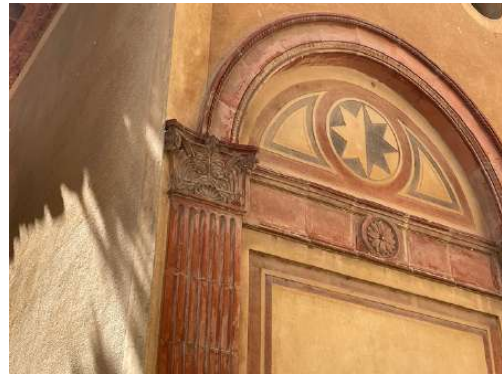
Fotografies detall de l'emblanquinament o empal·lidament de la superfície de la terracota per la entrada d'humitat
