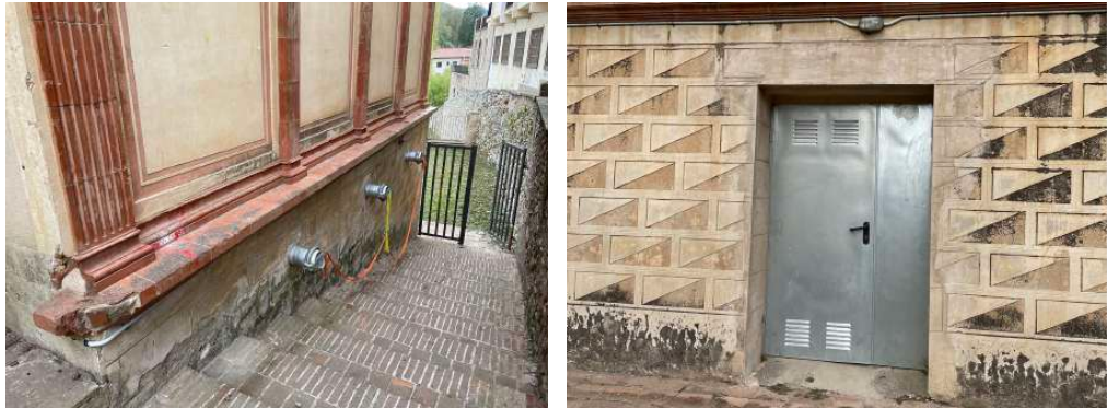
Fotografies detall de la modificació de les façanes per la instal·lació un nou servei de calefacció
