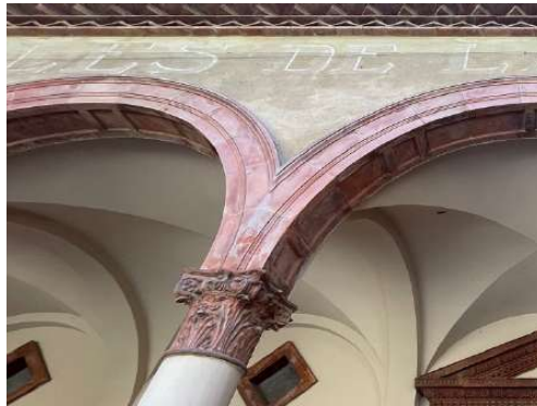
Fotografies detall de l'emblanquinament o empal·lidament de la superfície de la terracota per la entrada d'humitat
