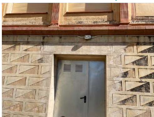
Fotografies detall dels morters de reparació
