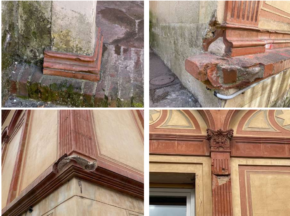
Fotografies detall de la pèrdua de suport, tant de petites pèrdues (esq.) com grans pèrdues de suport (dret.)
