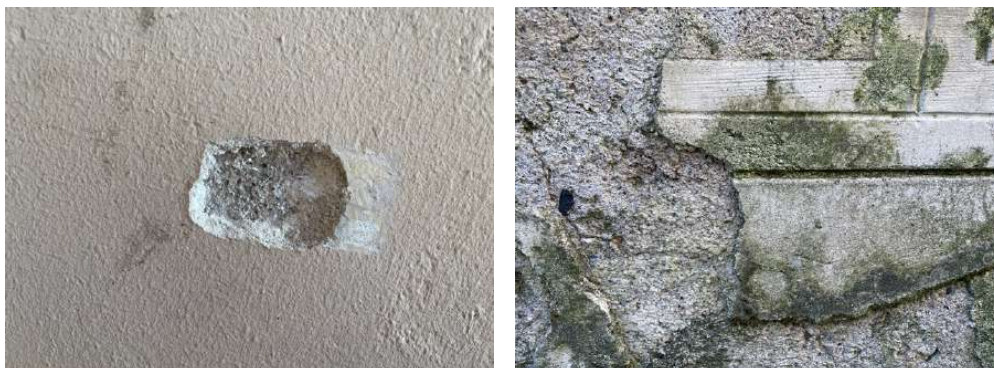
Fotografies detall on s'aprecia el sistema constructiu de l'arrebossat tipus 1 que regularitza totes les façanes
