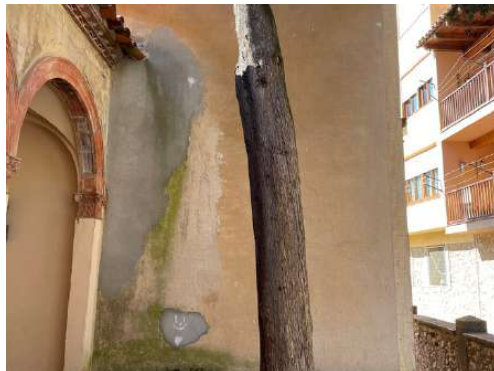
Fotografies detall dels morters de ciment pòrtland
