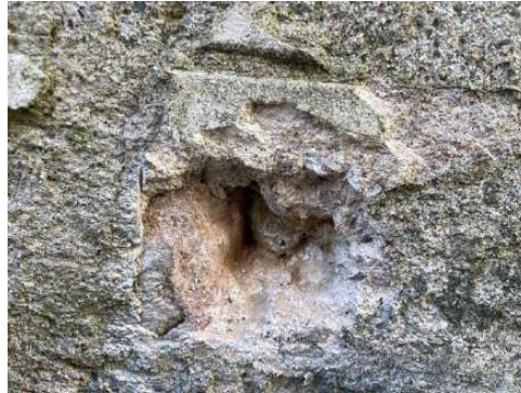
Fotografia detall de les cales on s'observa un fragment de mamposteria (esq.) i de maons (dret.)
