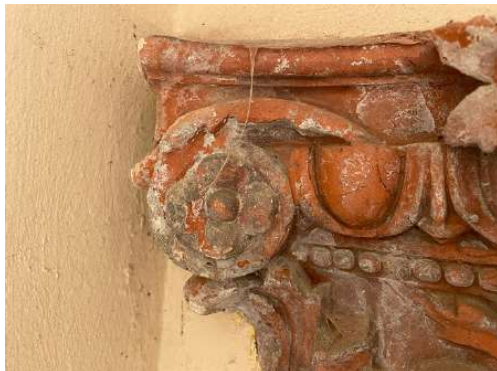
Fotografies detall de les efflorescències salines
