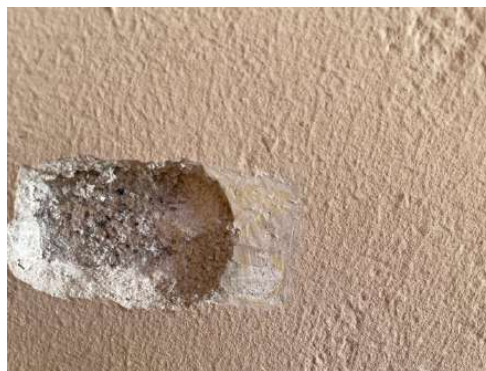
Fotografies detall on s'aprecia el morter M1 aplicat com a lliscat del interior del pòrtic principal
