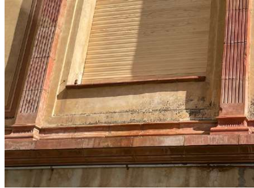
Fotografies detall de l'erosió de les peces ceràmiques amb la pèrdua de lluentor
