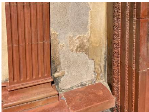
Fotografies detall de la falta d'adhesió entre capes i la conseqüent pèrdua de suport
