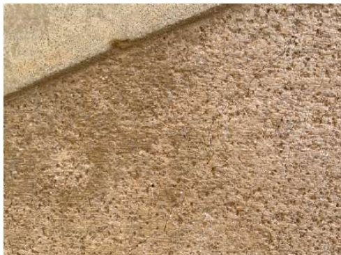
Fotografies detall del morter de base dels esgrafiats
