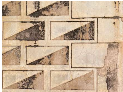
Fotografies detall del morter de base dels esgrafiats
