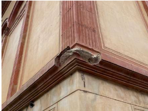
Fotografies generals i detall de les fractures i la conseqüent pèrdua de suport de les cantonades
