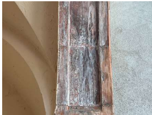
Fotografies detall de les efflorescències salines
