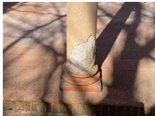
Fotografies detall de la falta d'adhesió entre capes i la conseqüent pèrdua de suport
