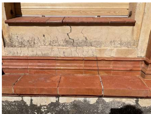
Fotografies detall de fractures presents a les peces ceràmiques
