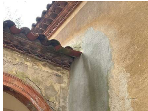
Fotografies detall dels morters de ciment pòrtland
