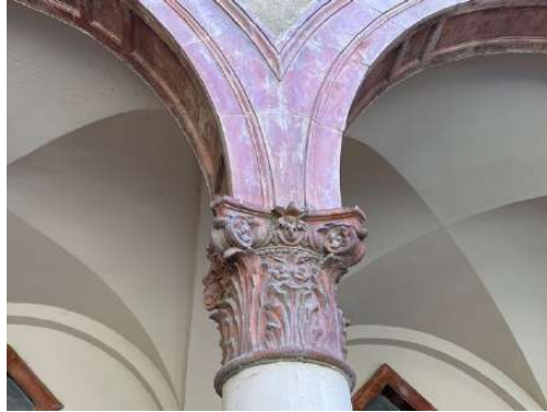
Fotografies detall de l'erosió de les peces ceràmiques amb la pèrdua de lluentor
