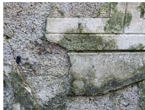
Fotografies detall on s'aprecia el sistema constructiu de l'arrebossat tipus 2 que anivella a totes les façanes
