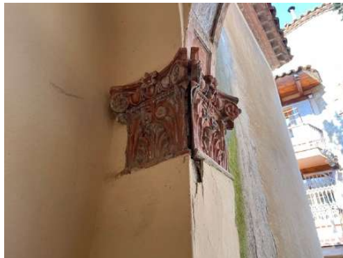
Fotografia detall del desplaçament de la cara anterior del capitell (esq.); detall de la fractura present a la dovella (dret.)
