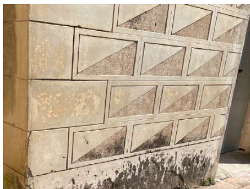
Fotografies detall del morter esgrafi de les façanes
