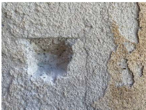
Fotografies detall on s'aprecia el sistema constructiu de l'arrebossat tipus 2 que anivella a totes les façanes
