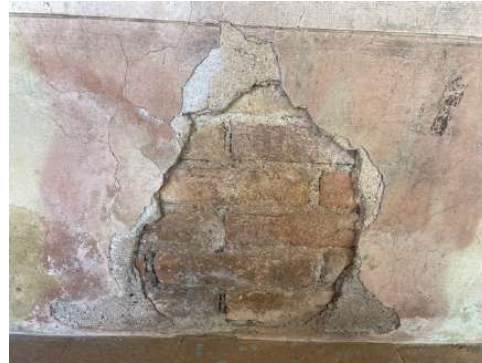
Fotografia detall de les cales on s'observa un fragment de mamposteria (esq.) i de maons (dret.)
