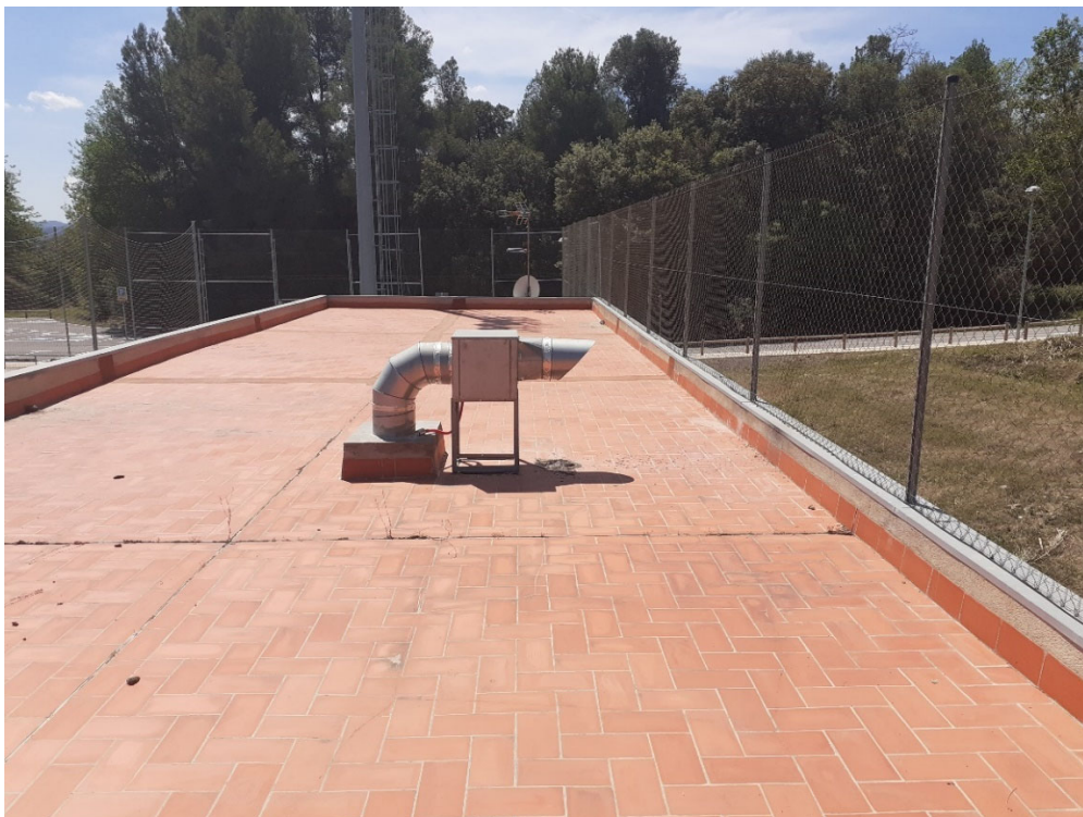
Imatge 17. Cobertes a impermeabilitzar, realitzant juntes.
