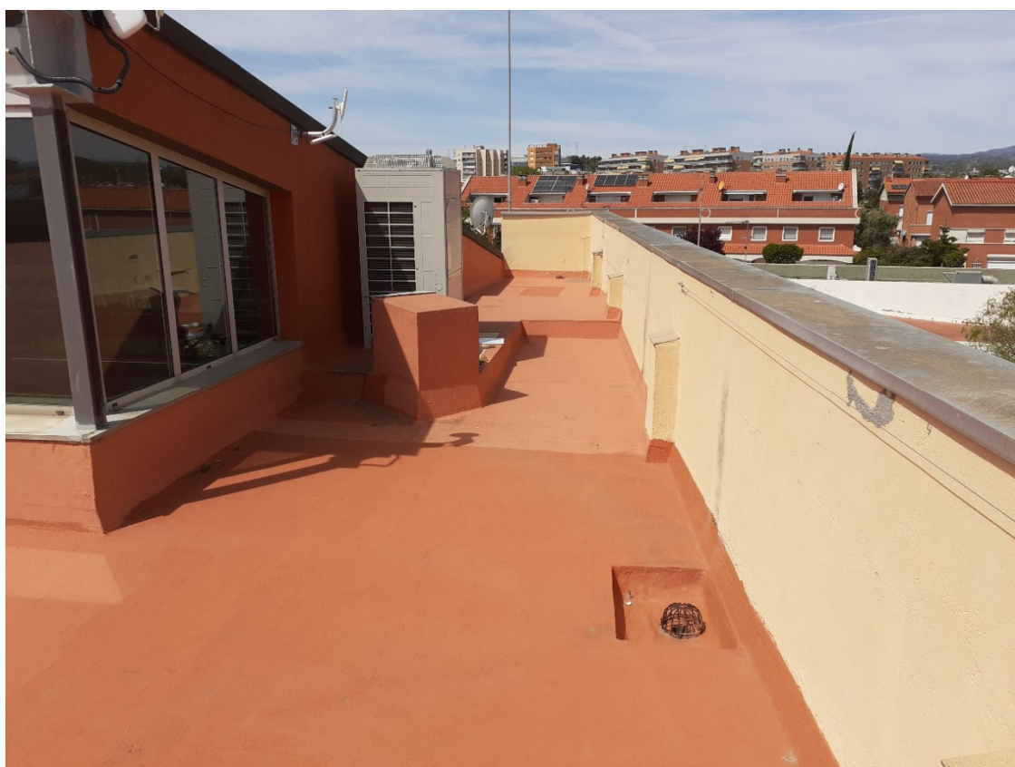
Imatge 3. Coberta costat Escola Bressol
