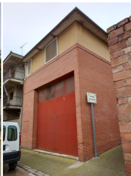
Vista de la façana nord del c. del Forn
