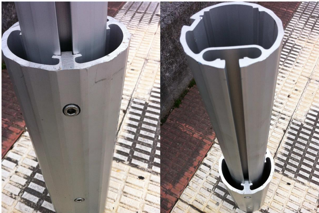
Figura 1: Detall de la transició i de la guia anti-rotació del pal telescòpic
