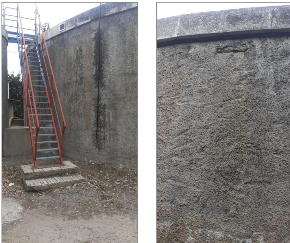
Figura 1. Parets exteriors del Dipòsit amb filtracions i armadures a la vista
