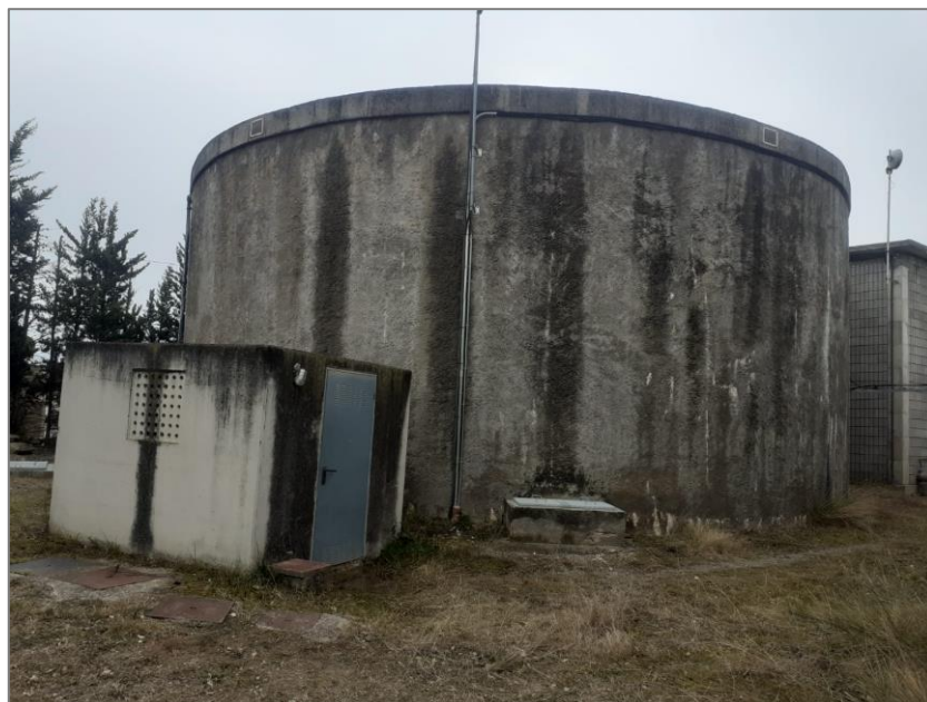
Figura 5. Vista general dipòsit capçalera
