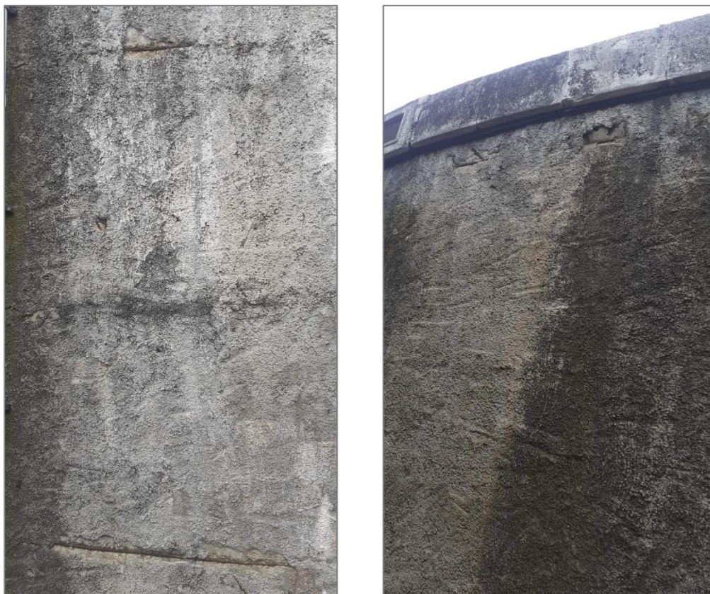
Figura 3. Parets exteriors del Dipòsit amb filtracions i armadures a la vista
