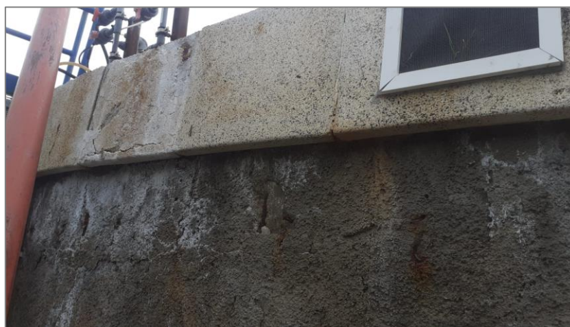
Figura 3. Parets exteriors del Dipòsit amb filtracions i armadures a la vista
