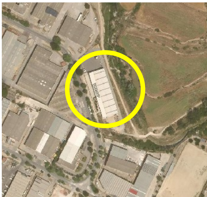
Imatge 1.- Emplaçament de l'edifici de les brigada municipal d'Igualada. (Font base: Institut Cartogràfic i Geològic de Catalunya)
