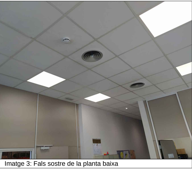
Imatge 3: Fals sostre de la planta baixa
