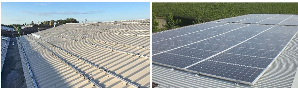
Figura 5.- Exemple d'estructura coplanar sobre teulada trapezoidal model Basic-Rail (Font: K2 Systems)
