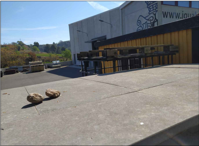
Imatge 3 - Coberta armari existent
