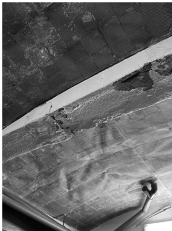
Canal de recogida de aguas
