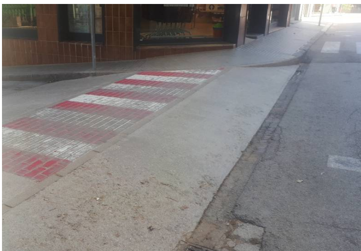
Imatge del pas elevat del C. Rocosa.
