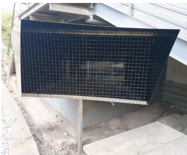
Exemple de moble amb reixa frontal i visera de protecció contra incidència del sol.
