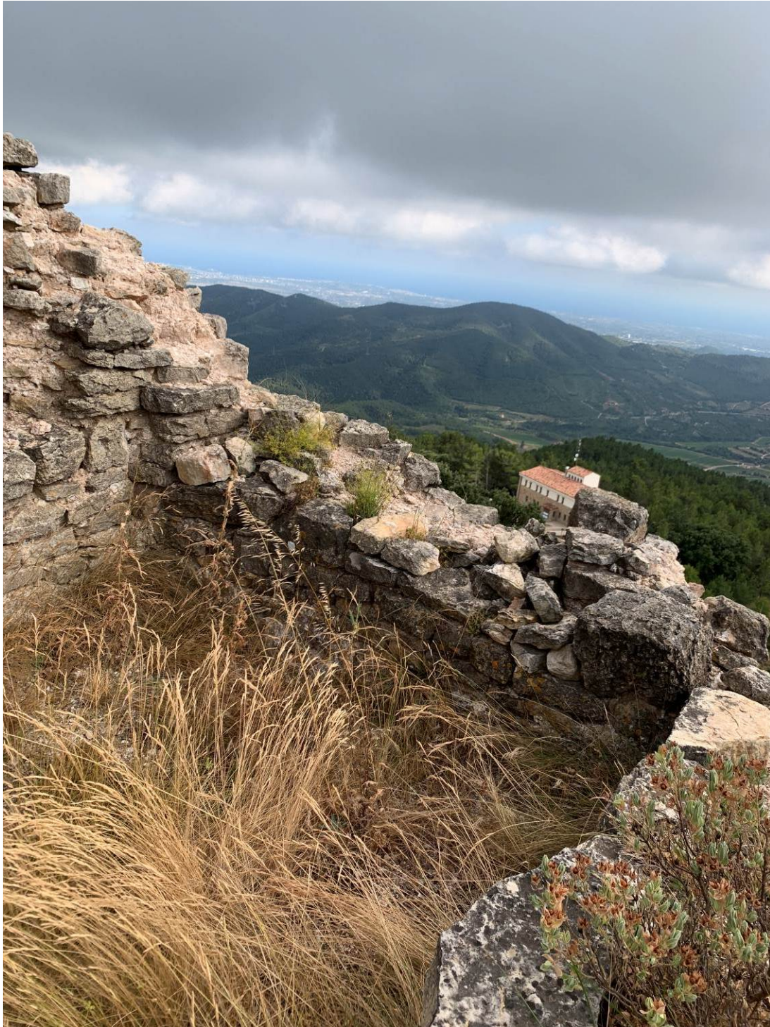
Torre sud a consolidar.
