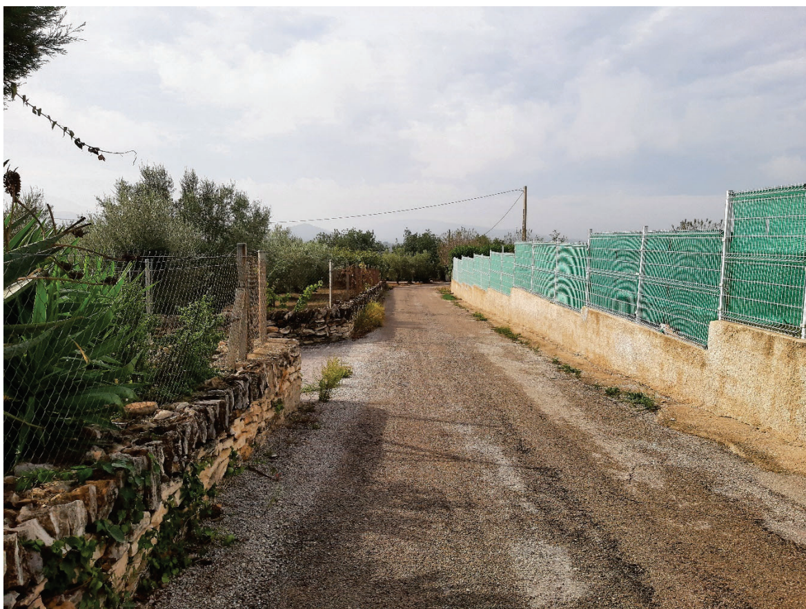
Foto 23. Paviment desgranat entre tanques
