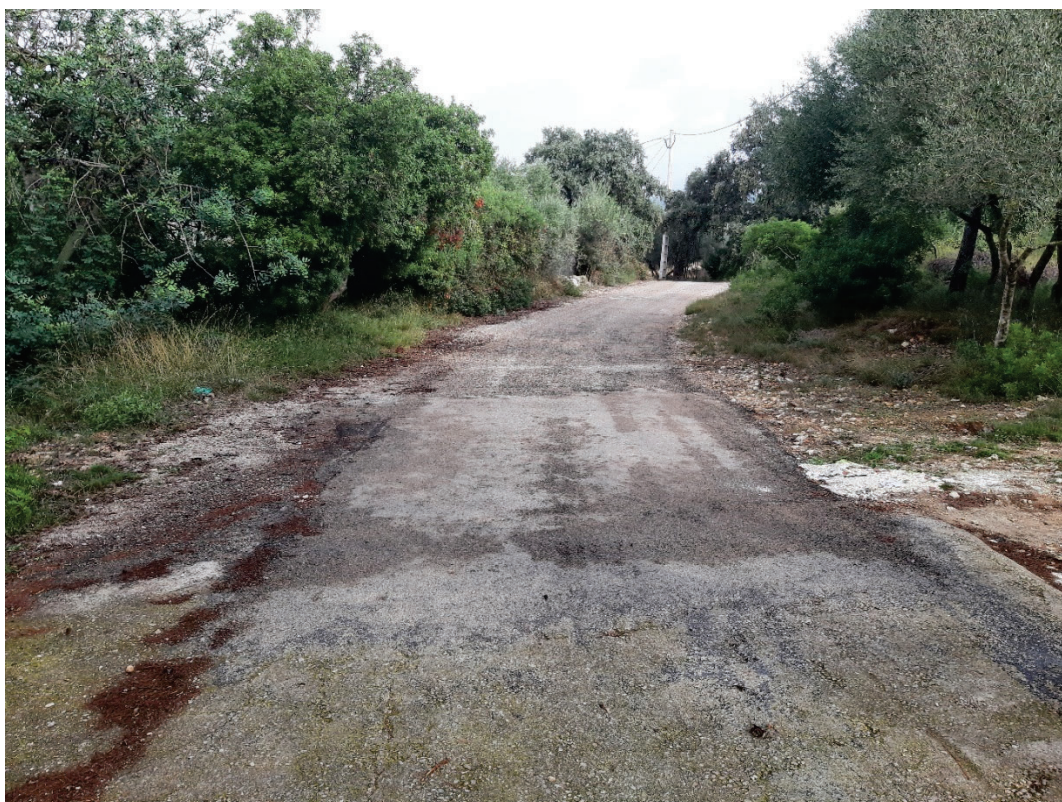
Foto 13 i 14. Paviment desgranat. Diferents trams.
