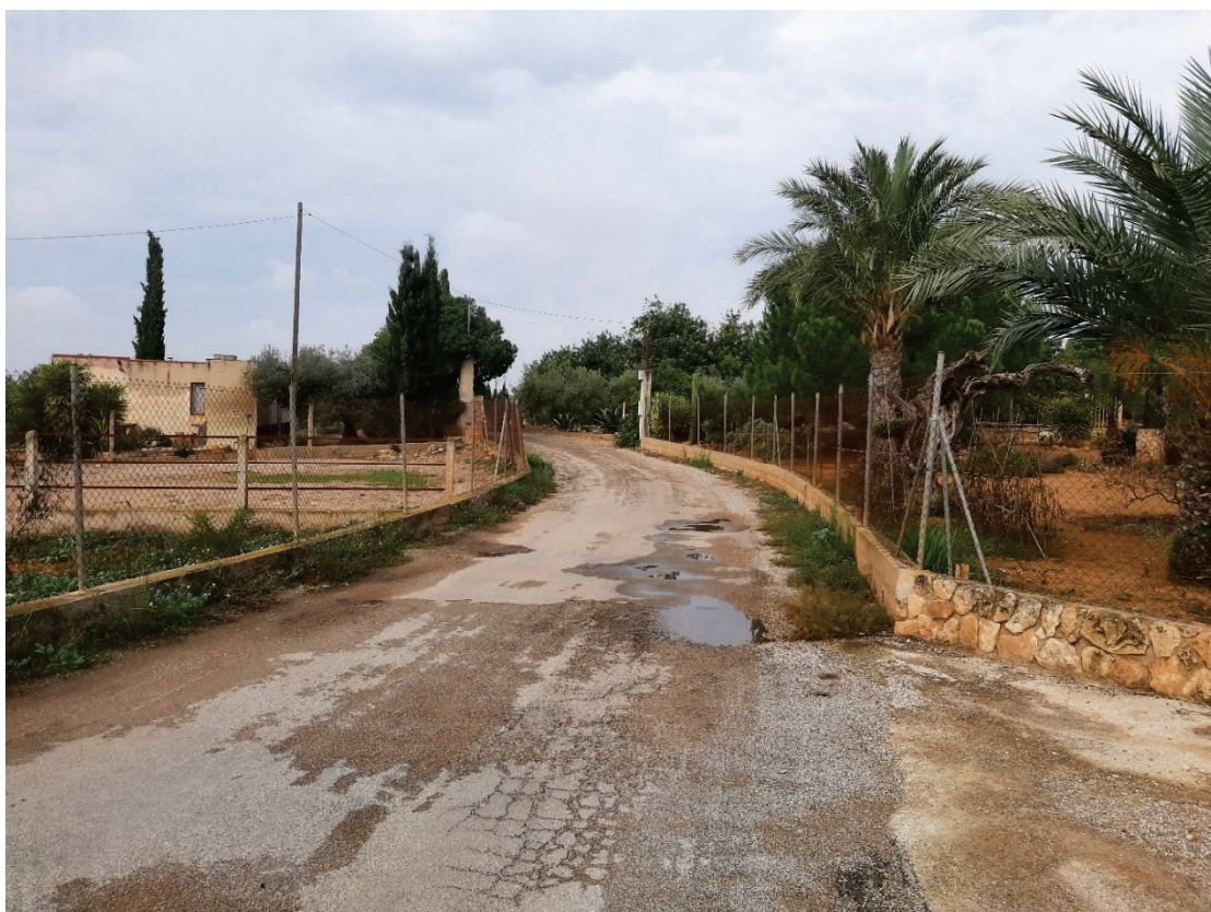
Foto 25. Sots a corregir per evitar acumulació d'aigua
