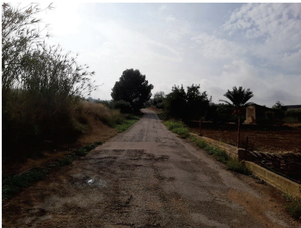
Foto 1. Tram inicial de camí. Desgranats i sots puntuals.
