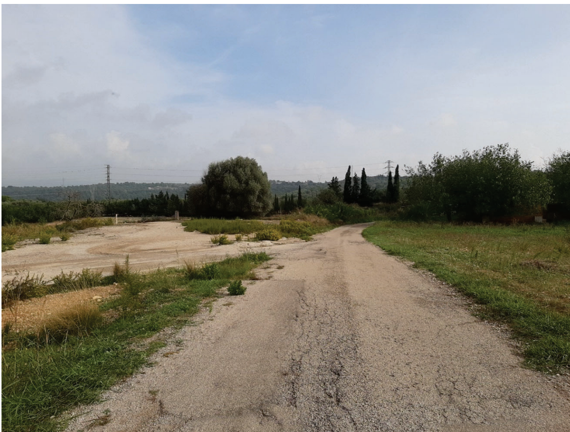
Foto 7 i 8. Vistes generals. Paviment parxejat i desgranat.
