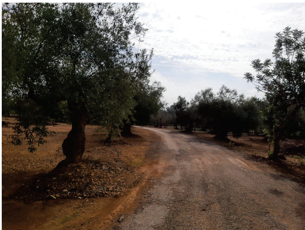
Foto 21 i 22. Paviment desgranat i amb sots entre finques agrícoles i casetes de camp
