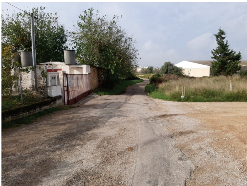
Foto 5 i 6. Zona accés granges. Paviment desgranat
