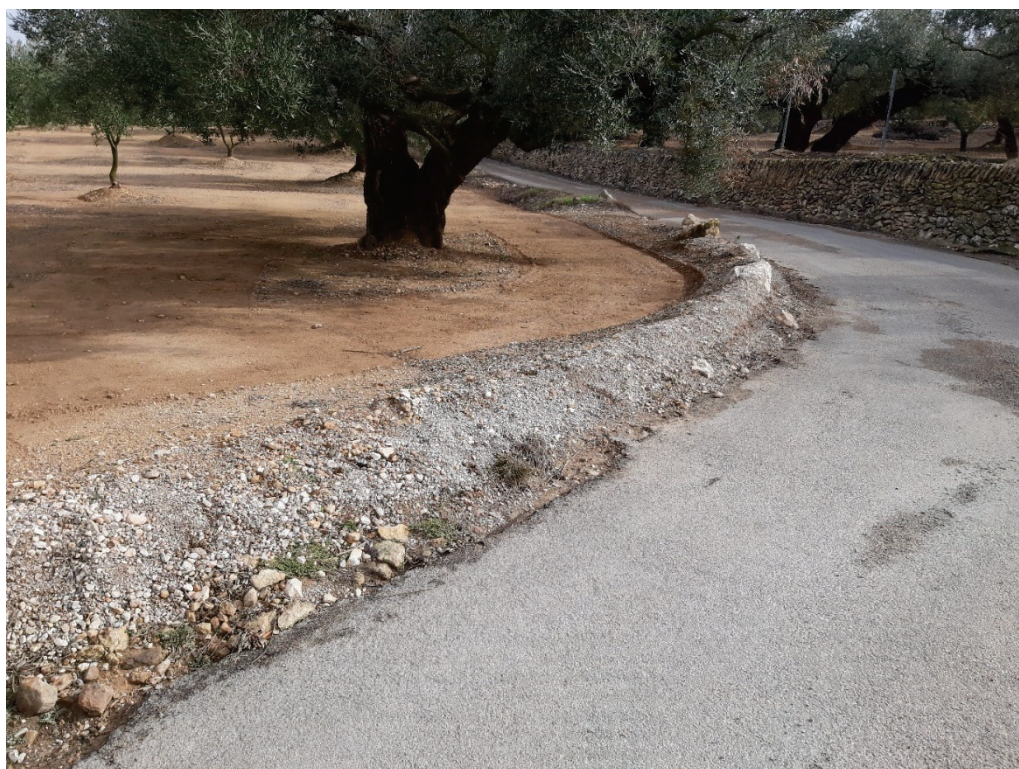
Foto 9. Aigua canalitzada cap el punt baix. Inici de cuneta.
