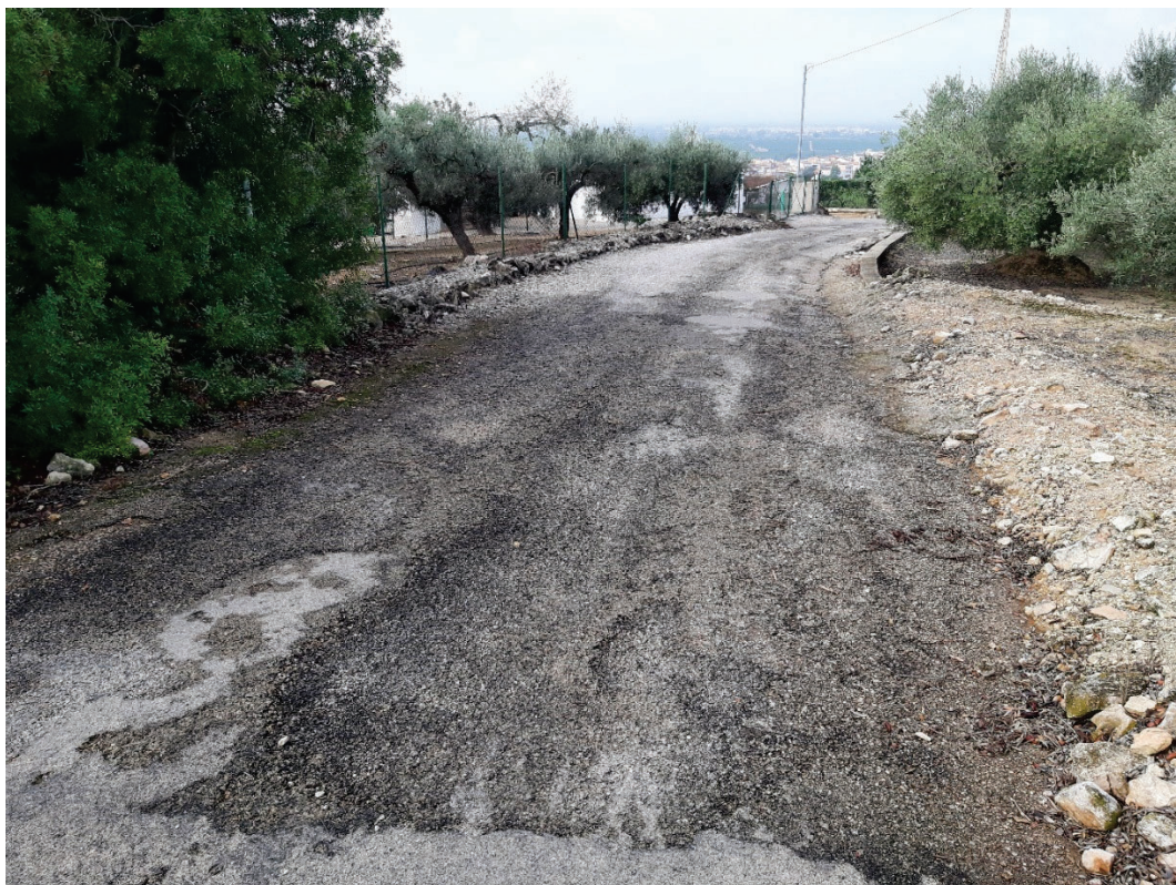
Foto 18. Paviment desgranat
