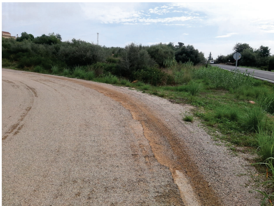
Foto 28. Lateral de corba a ampliar en franja 1 m d'amplada.
