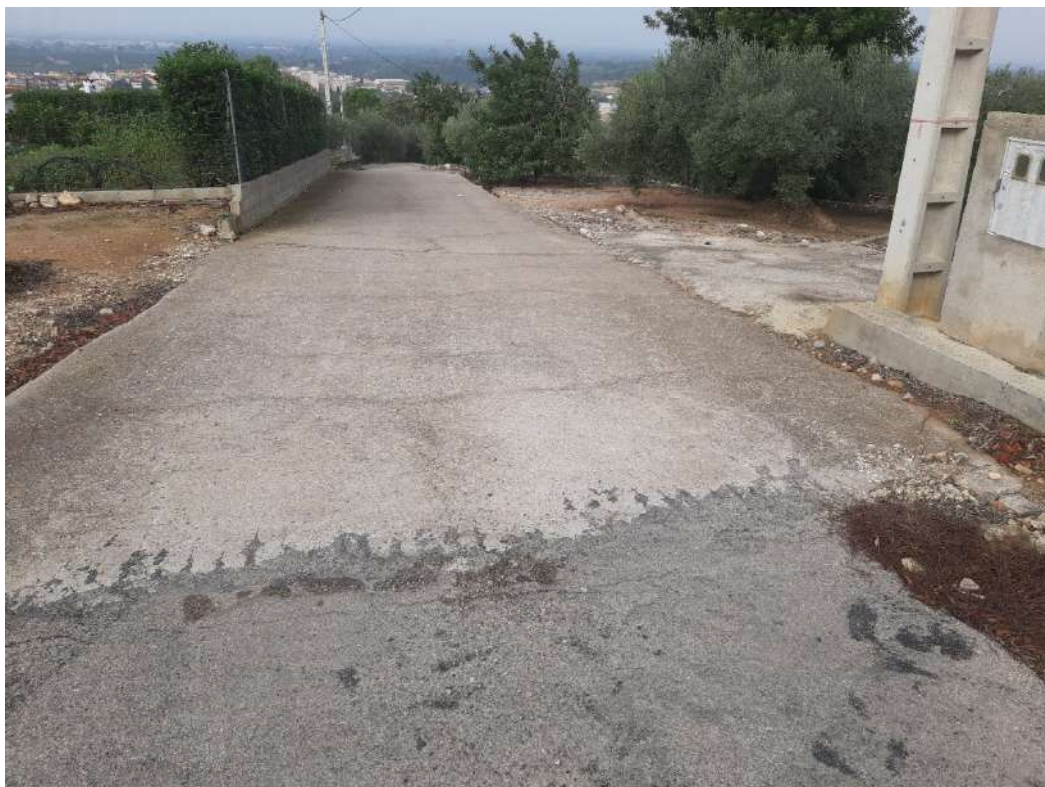
Foto 17. Entrega a formigó. Punt inicial tram 2, aigües amunt.
