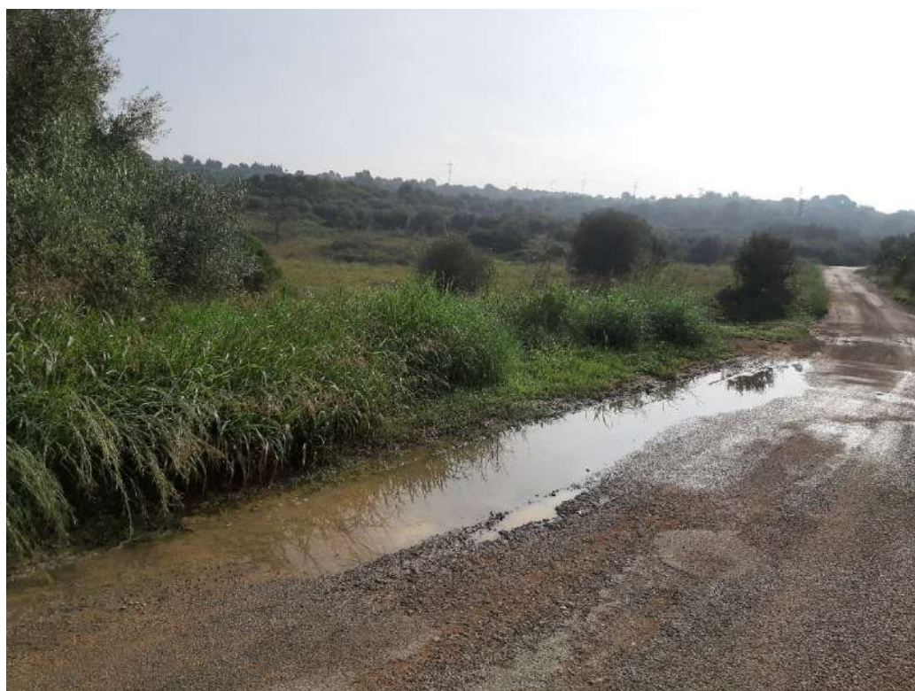
Foto 2. Punt d'acumulació d'aigua. Desgranats superficials.
