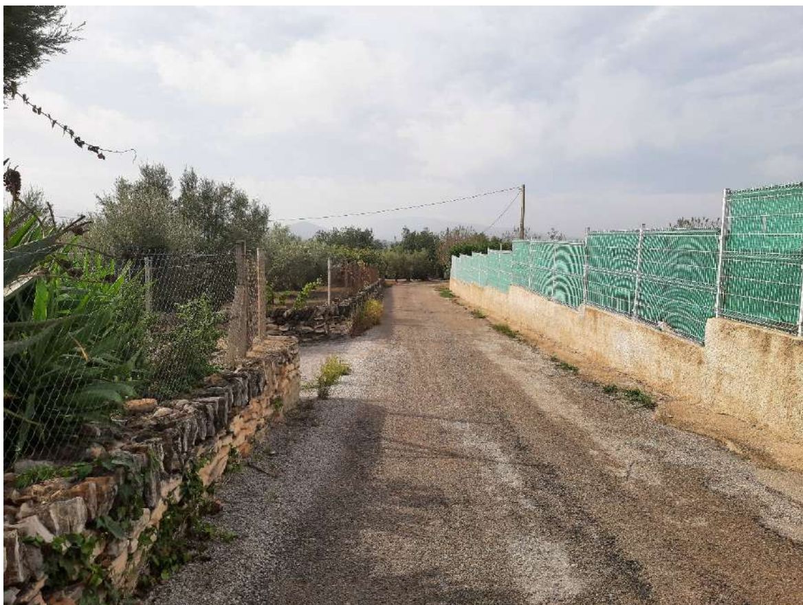
Foto 23. Paviment desgranat entre tanques
