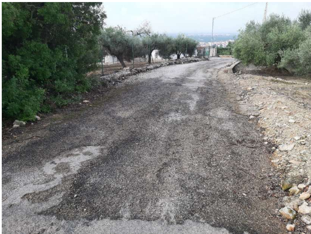
Foto 18. Paviment desgranat
