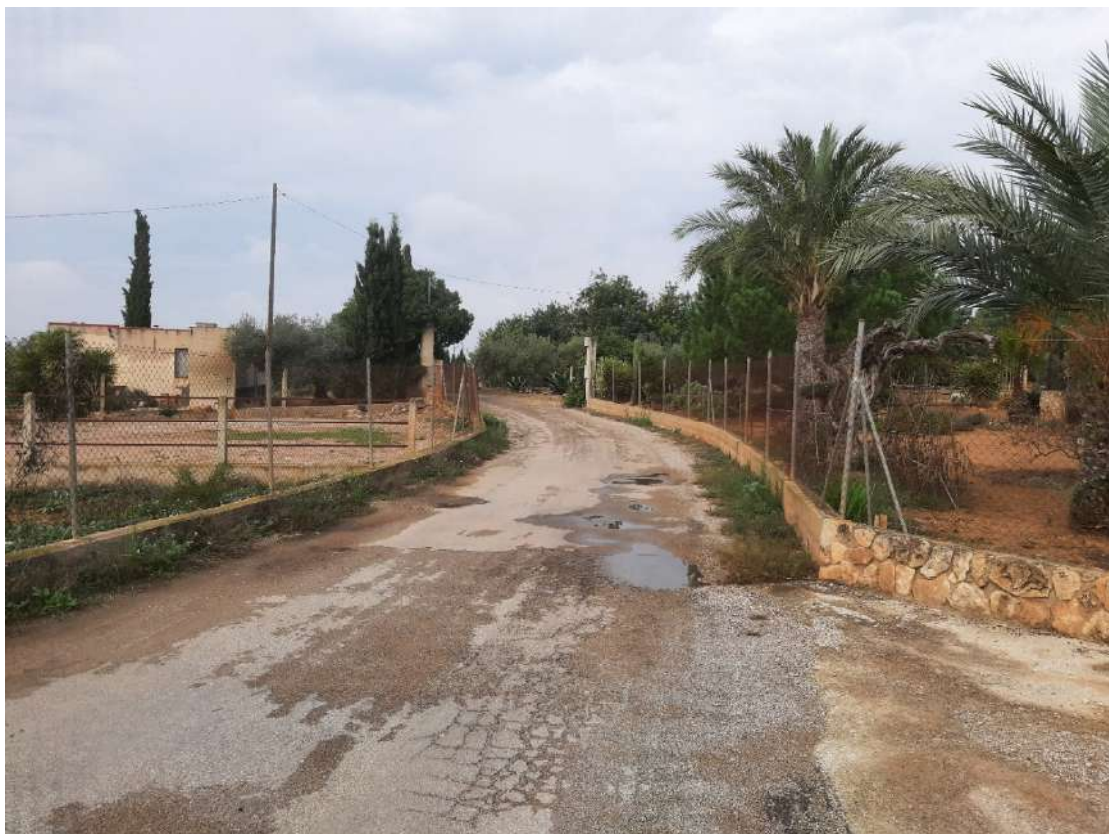
Foto 25. Sots a corregir per evitar acumulació d'aigua
