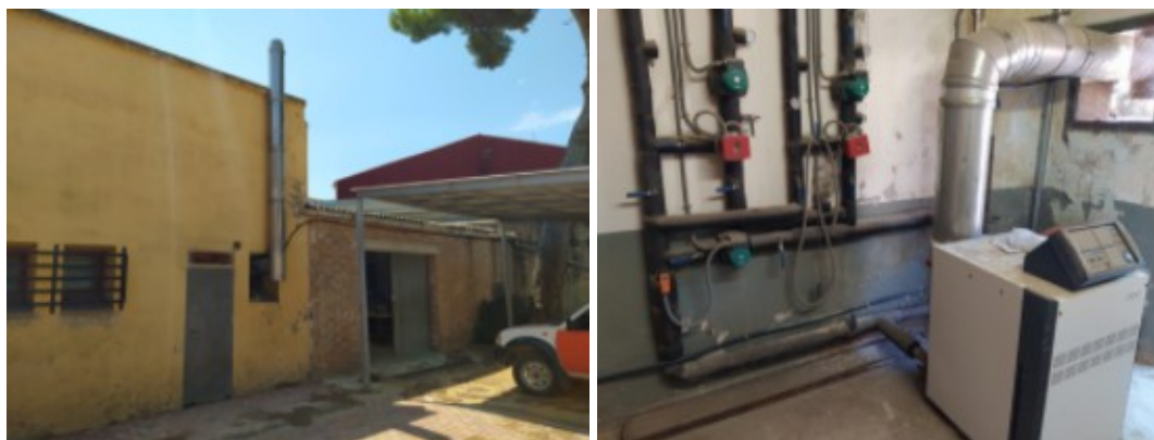
Imatges 2 i 3.- Exterior i interior de la sala de calderes existent.
