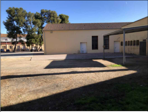
Imatge 4.- Ubicació sala de caldera de Biomassa
