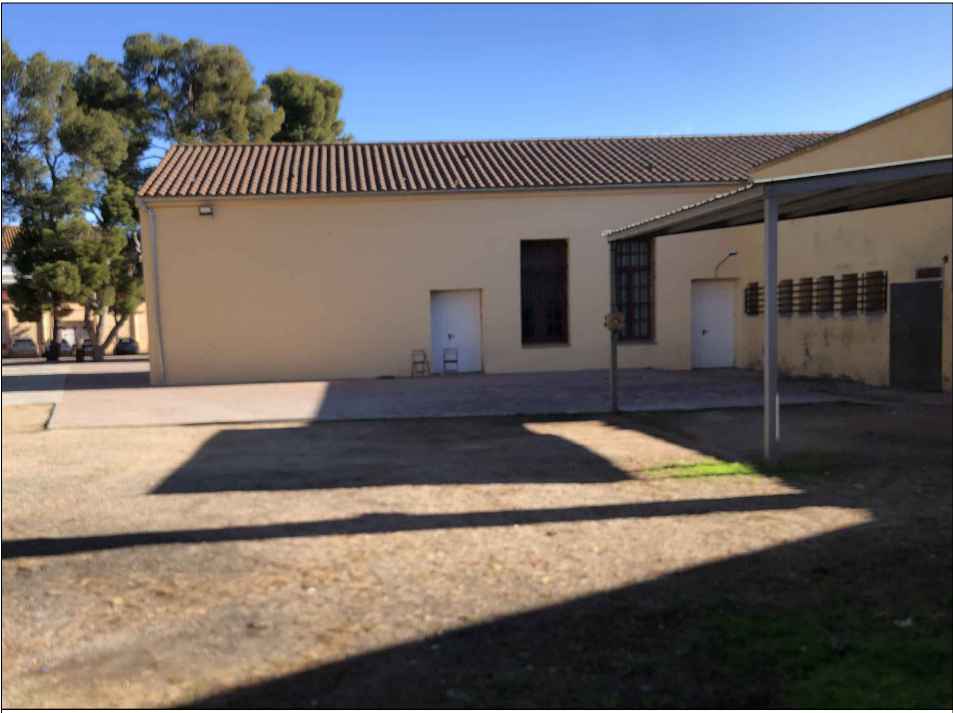
Imatge 1.- Ubicació sala de caldera de Biomassa
